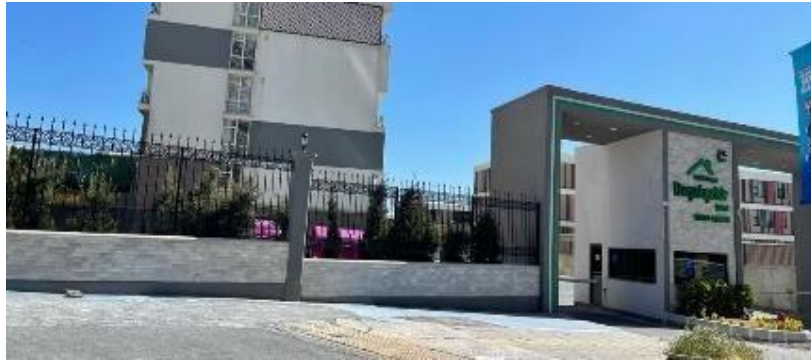
Şekil 7.9 Bahçeşehir Evleri 1. Etap Kentsel sınır elemanları: 2 m. altında betonarme duvar ve demir parmaklık
