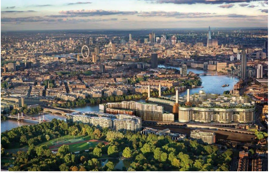
Şekil 3.8 Battersea Elektrik Santrali kentsel yenileme projesi, Londra/İngiltere(URL 7)
