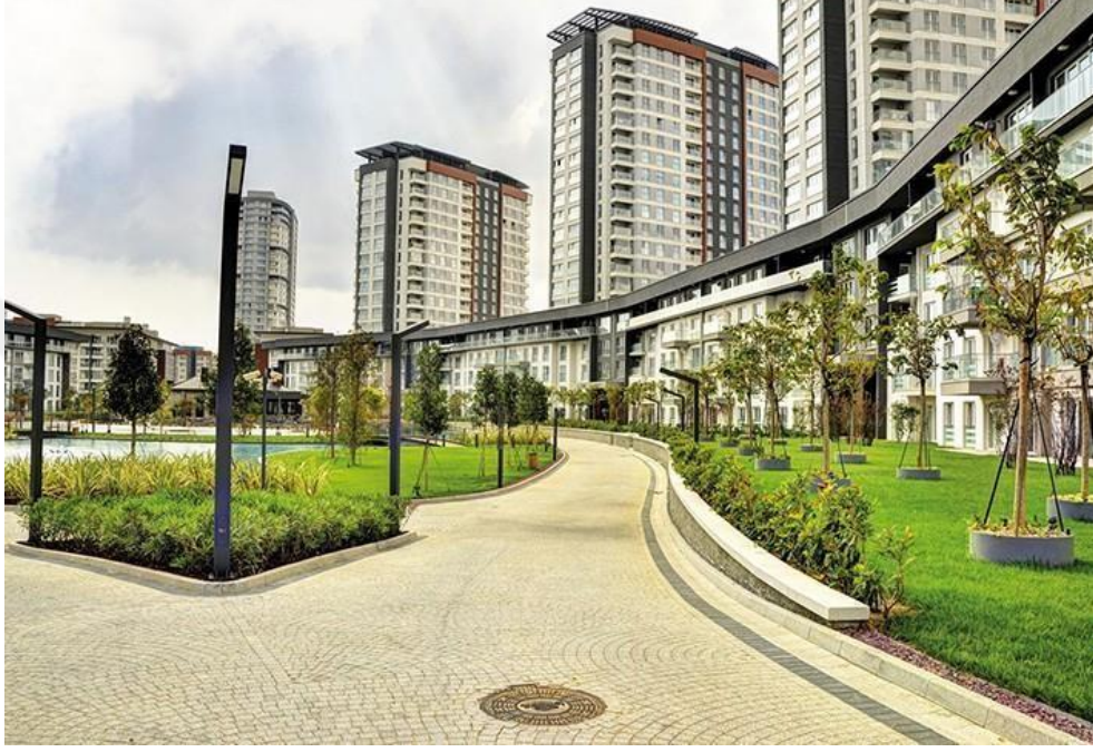
Şekil 6.33 Tema İstanbul'da sunulan alçak ve yüksek katlı konut bloklarında cephe şekillenışı, Küçükçekmece/İstanbul, 2017 (URL 88)
