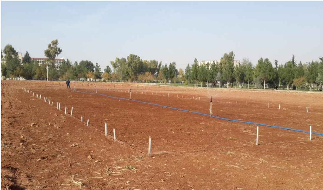
Şekil 3.15. Yağmurlama sulama tesisinin kurulması ve uygulaması ile ilgili görüntüler.
