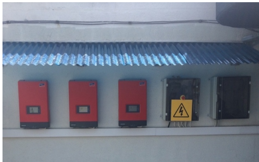
Şekil 3.4. Fotovoltaik paneller için kullanılan üç adet invertör cihazı (kırmızı cihaz) ve kontrol cihazları (siyah cihaz).
