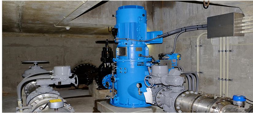
Şekil 2.4. Boru İçi Türbin [9]
