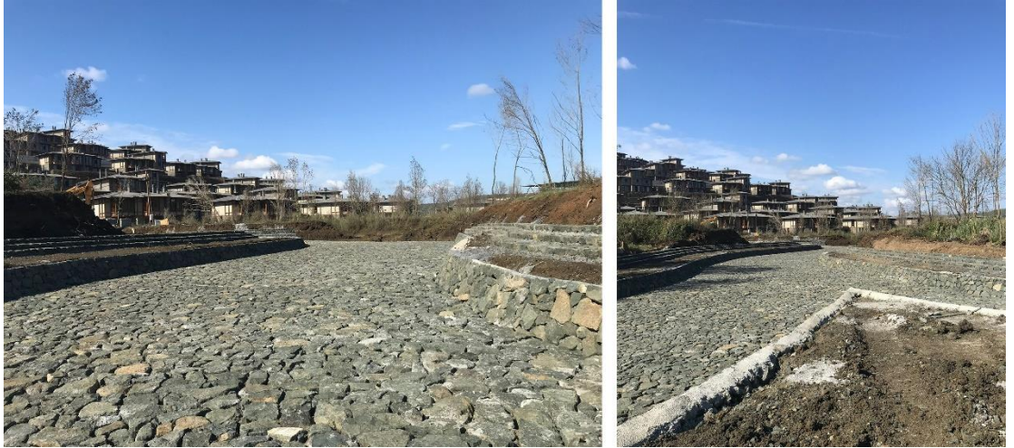
Şekil 57. Çalışma alanı geçirgen kaplamalar uygulama örneği (Orijinal, 2022)
