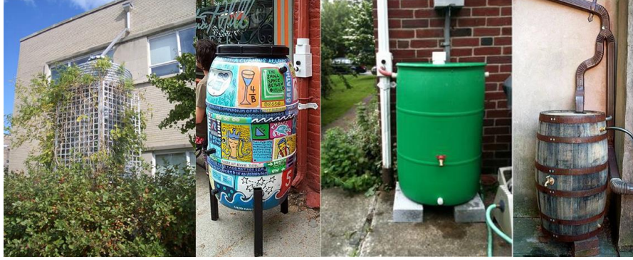
Şekil 8. Yağmur toplama sistemleri (Semiz, 2016)
