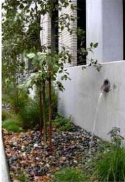
Şekil 7. Downspout kesilmesi (Yağmur İnişi) bir örnek (EPA, 2022)
