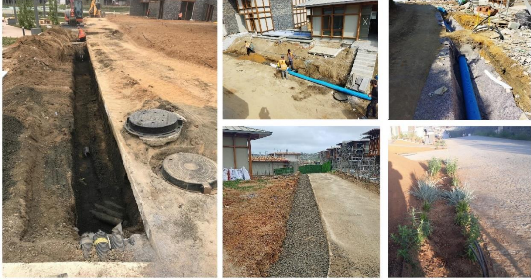
Şekil 43. Çalışma alanı bioswale sistemi uygulama aşamaları (Orijinal, 2022)
