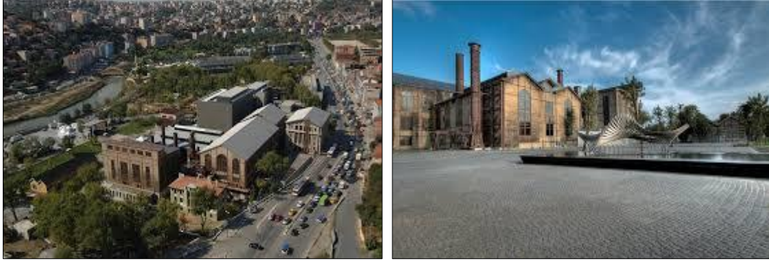
Resim 5.11. Santral İstanbul dönüşüm sonraki hâli (Santral İstanbul, 2021)
