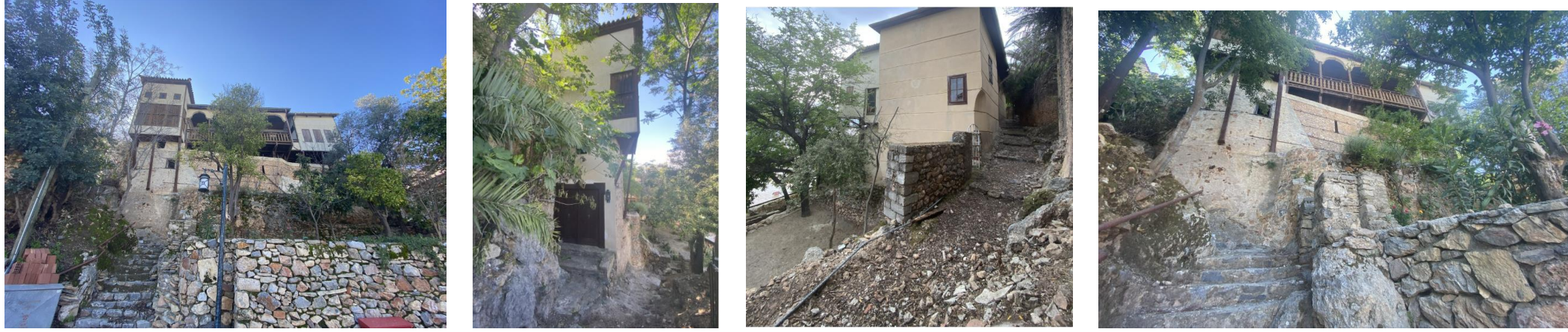
Şekil 4.24 Kültür varlığı 10'a ait dış mekân fotoğrafları
