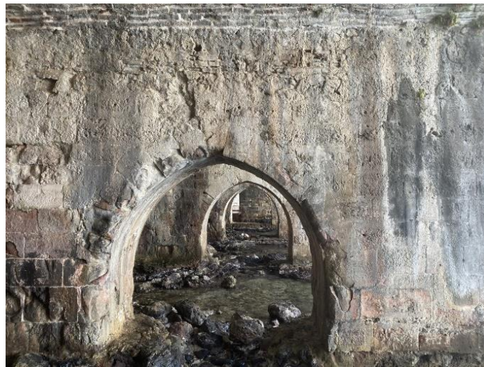
Şekil 2.24 Tersane içindeki kemerler
