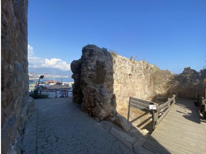
Şekil 2.18 Eğri Kule ve Kızıl kule'nin yıkılan bağlantısı
