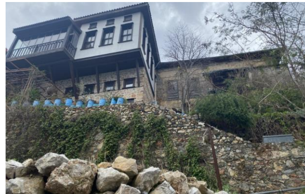
Şekil 4.41 Kùltür varlığı 20'ye ait dış mekân fotoğrafları
