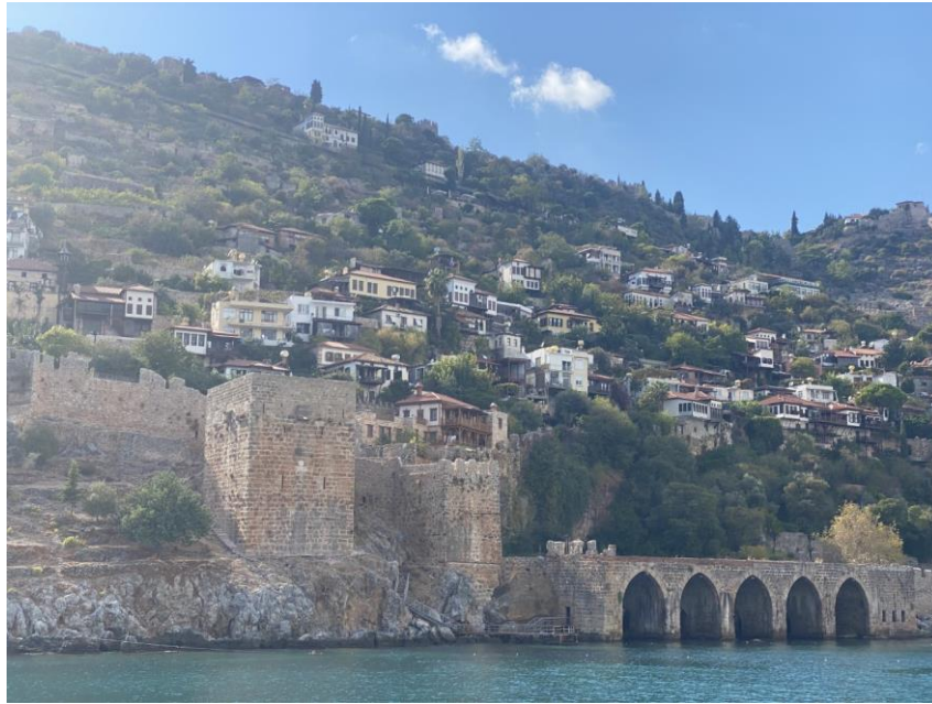
Şekil 3.7 Tophane Mahallesi Evleri'nin denizden görünüşü
