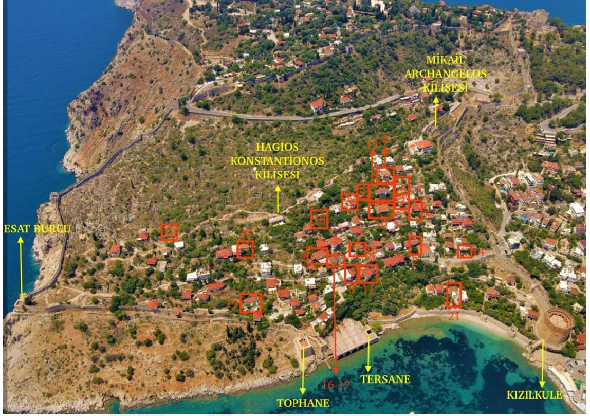
Şekil 4.6 İncelenen 21 kültür varlığının Tophane Mahallesi içindeki konumları
