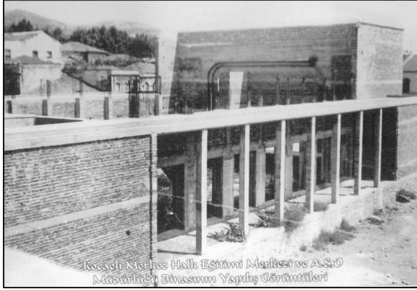
Şekil 5.11: İzmit Halkevi Binasının Yapımı
