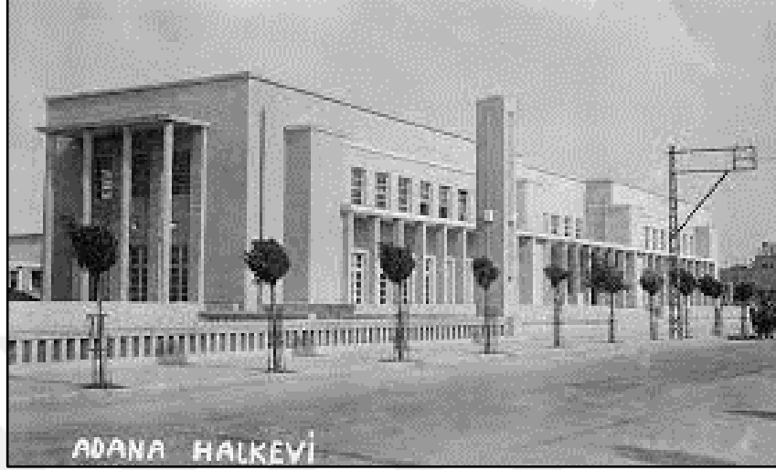
řekil 4.27: Adana Halkevi Binasının Kolonatl  Giriři
