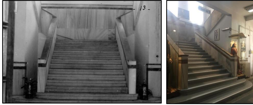
Şekil 5.12: İzmit Halkevi Bina Giriş Merdiveni
