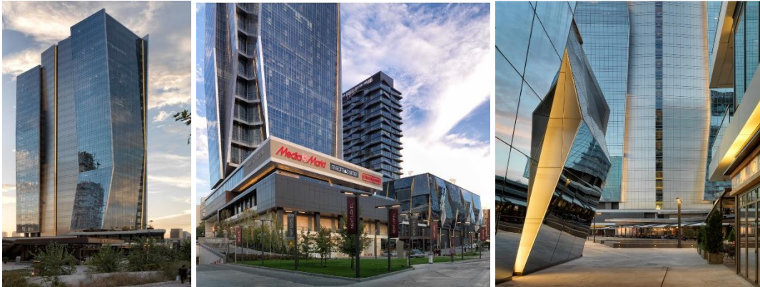
Şekil 4.28. Next Level ofis yapısı genel görünüm ve cephe detayları
