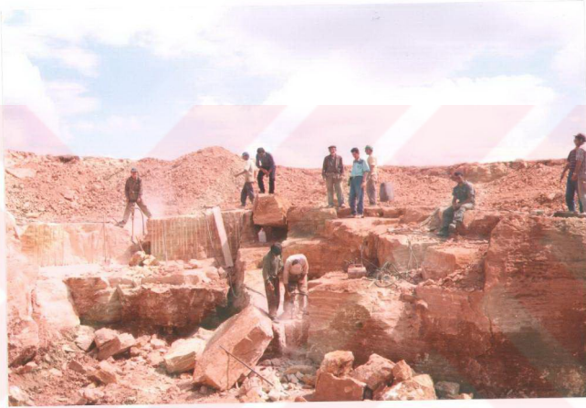
Şekil 3.9: Karlıkaya travertenlerinde, işletme faaliyetlerinden bir görünüm ve blok çıkarımı (Batıdan doğu görünüşü)
