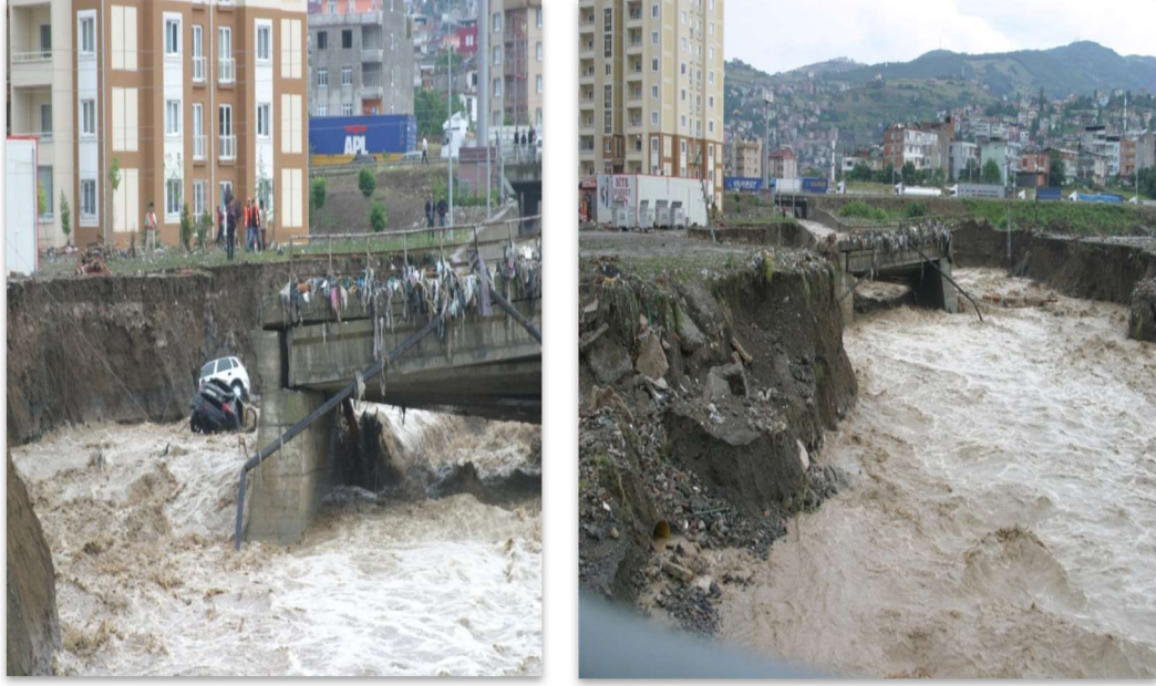
Şekil 3.10. 2012 yılında meydana gelen Mert Irmağı ve Yılanlıdere taşkını
