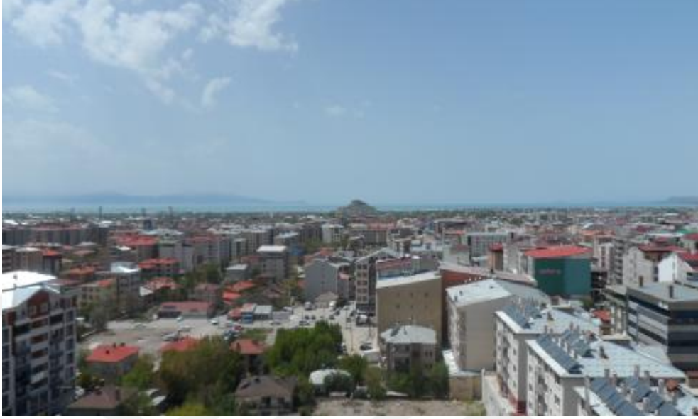
Şekil 4.3. Van Kent yerleşiminin bir bölümü
