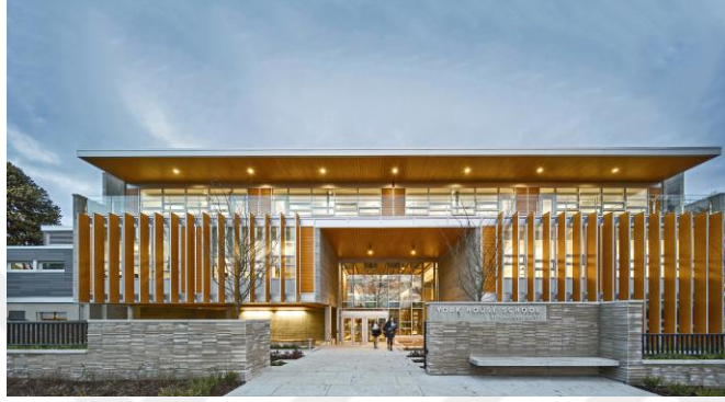
Şekil 4.21 : Lise binasında düşey gölgeleme elemanlarının kullanımı (URL-21).
