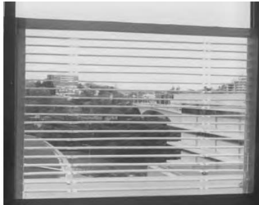
Şekil 4.13 : Lazer kesim panellerin güneş kırıcı sistem olarak kullanılması (IEA, 2000).
