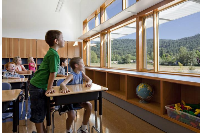
Şekil 4.17 : Sınıflarda ışık rafının kullanımı (URL-18).
