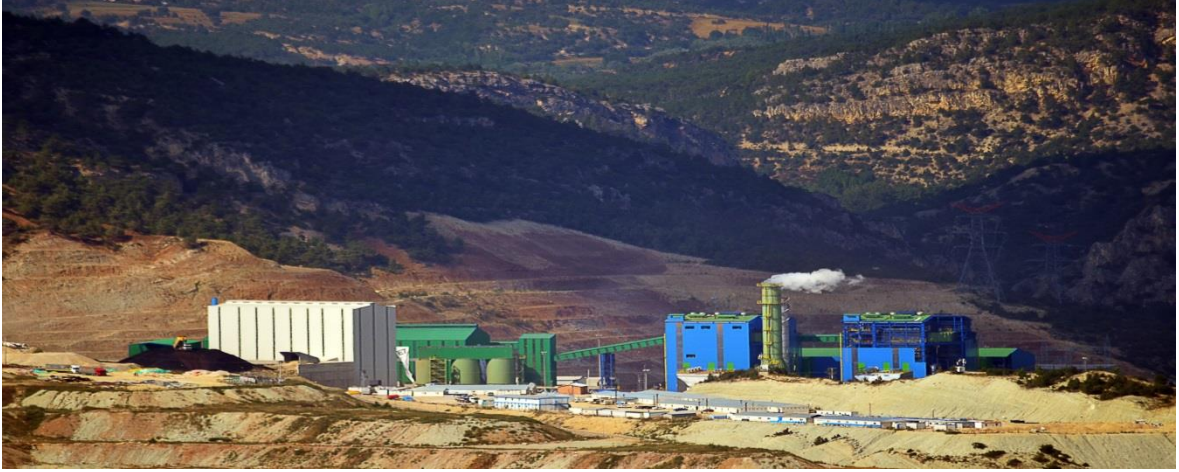
Şekil 4.5. 260 kW termik santrale ait bir görünüm
