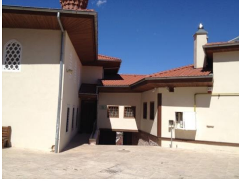
Şekil 3.103. Üftade Tekkesi restorasyon sonrası arka bahçe girişi (Taşkın C., 2015).
