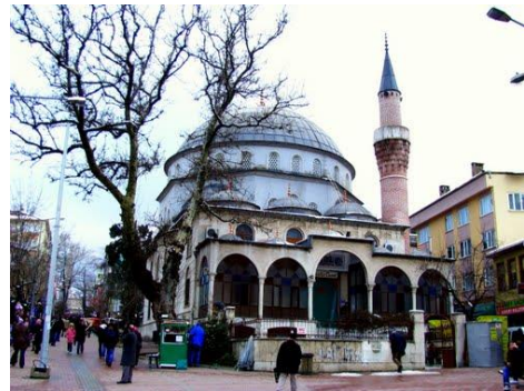
Şekil 3.18. Bedreddin Pars Bey Tekkesinin tevhidhanesinin yerine yapılan betonarme cami (Taşkın C., 2015).
