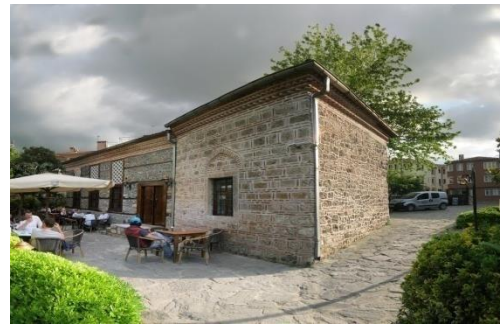
Şekil 3.139. Cizyedarzâde Tekkesi restorasyondan sonra tevhidhane ve kütüphanesi (Osmangazi Belediyesi Arşivi).
