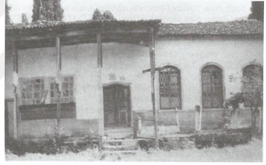
Şekil 3.185. Bursa Mevlevihanesi türbe giriş cephesi mihrap cephesi yıkılmadan önce harabe hali (BVBMA).
