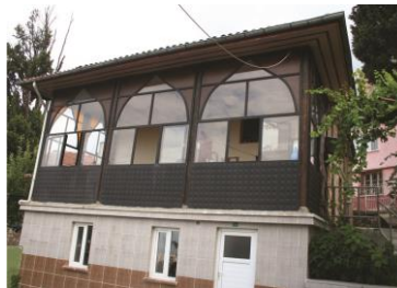
Şekil 3.118. Hüsameddin Tekke tevhidhane ön cephesi (Taşkın C., 2015).
