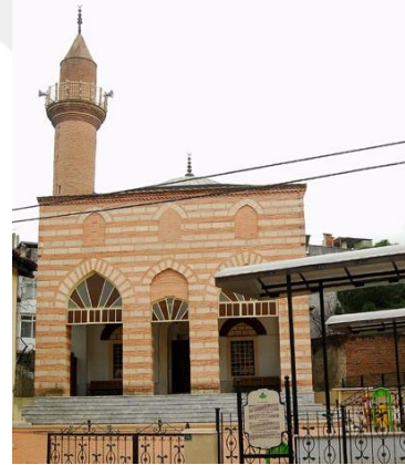
Şekil 3.80. Bahri Dede Tekkesi'nin 2007 restorasyonundan sonra son cemaat mahalli eklenen tevhidhanesi.
