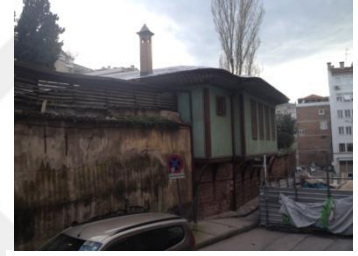
Şekil 3.160. Numaniye Tekkesi selamlık arka cephesi ve bakımsız bahçe duvarları (Taşkın C., 2015).
