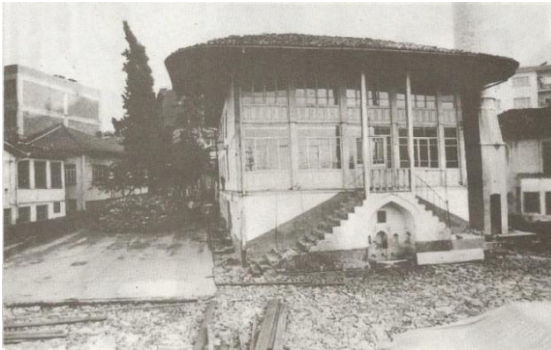
Şekil 3.147. İsmail Hakkı Tekkesi'nin yıkılıp B.A yapı inşa edilmeden önceki hali [12,201].
