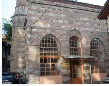
Şekil 3.10. Akbıyık Sultan Camii (Taşkın C., 2015).
