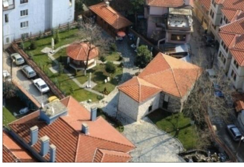
Şekil 3.140. Cizyedarzâde Tekkesi restorasyondan sonra (Osmangazi Belediyesi Arşivi).
