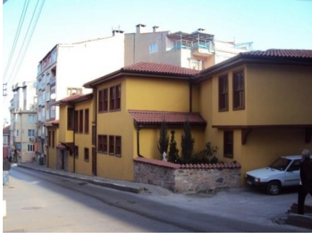
Şekil 3.164. Şabani Tekke restorasyondan önce (Taşkın C., 2015).
