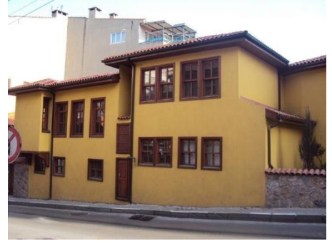
Şekil 3.165. Şabani Tekke restorasyondan önce (Taşkın C., 2015).
