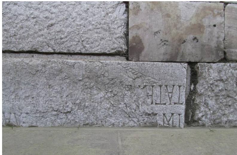
Şekil A.40 : Yörgüç Paşa İmareti duvar örgüsünde devşirme malzeme.
