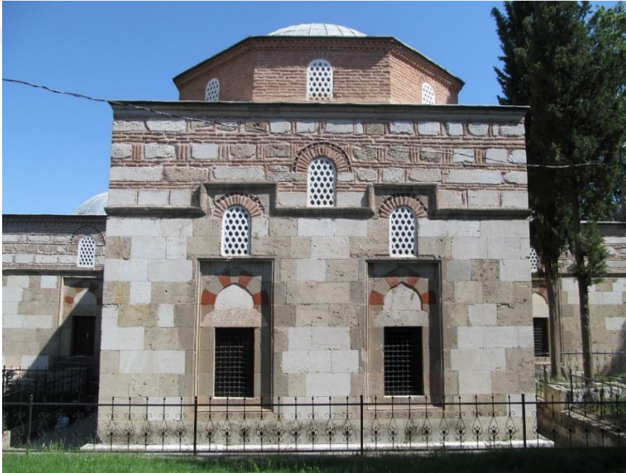
Şekil A.205 : Amasya Bayezid Paşa İmareti güney cephesi.
