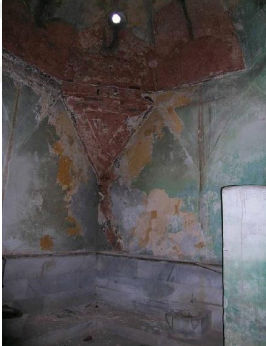
Şekil A.194 : Hızır Paşa Hamamı ılıklik mekanı (Oltulu).
