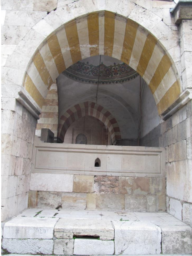
Şekil A.23 : Yörgüç Paşa Türbesi batı cephesi.
