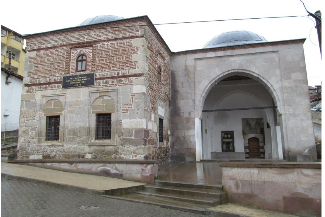
Şekil A.45 : Mustafa Bey İmareti güney cephesi ve giriş sundurması.
