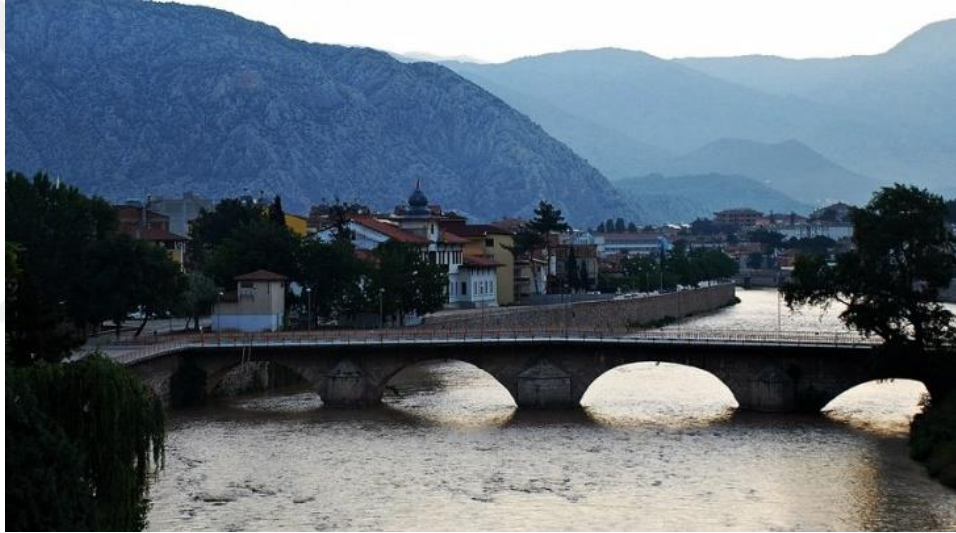
Şekil A.202 : Amasya Kuş (Kunç) Köprüsü.
