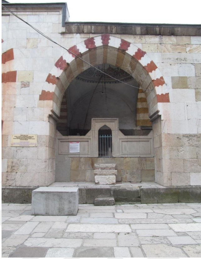
Şekil A.22 : Yörgüç Paşa Türbesi kuzey cephesi.
