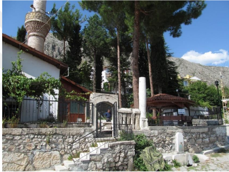
Şekil A.58 : Hızır Paşa İmaretı avlu girişı ve duvar çeşmesi
