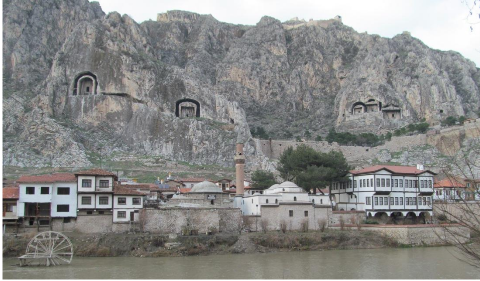
Şekil A.201 : Yeşilirmak kuzey istinat duvarı, Hatuniye Külliyesi.
