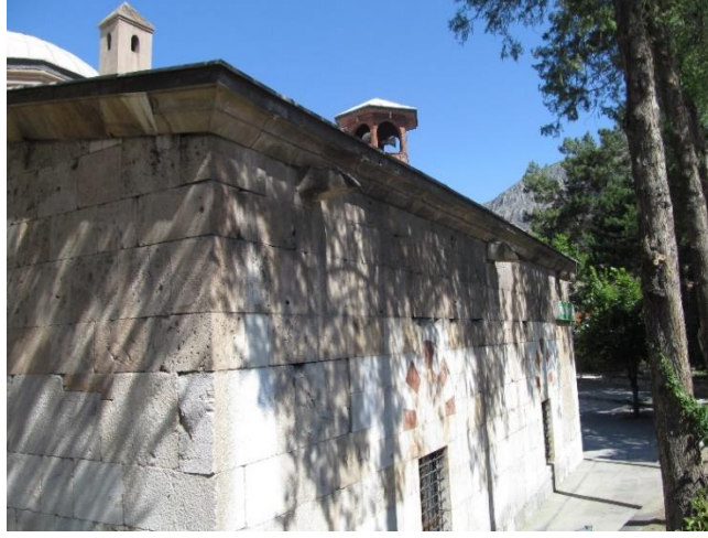
Şekil A.27 : Yörgüç Paşa İmareti doğu cephesi.
