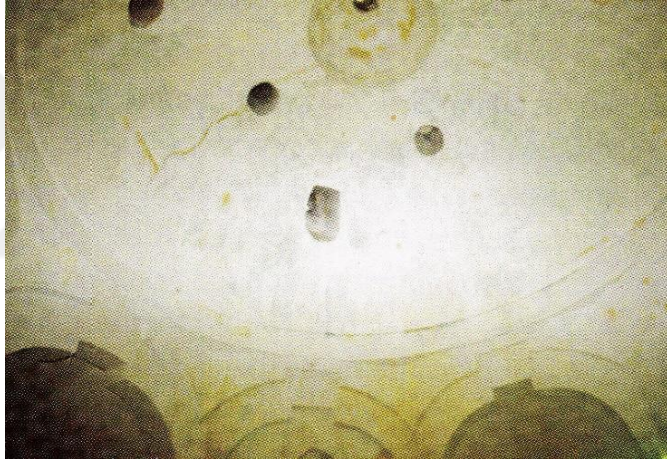
Şekil A.176 : Havza Mustafa Bey Hamamı ılıkılık kubbeye geçiş elemanı (Kula Say).
