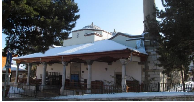
Şekil A.102 : Gümüş Yörgüç [Rüstem] Paşa Camisi.
