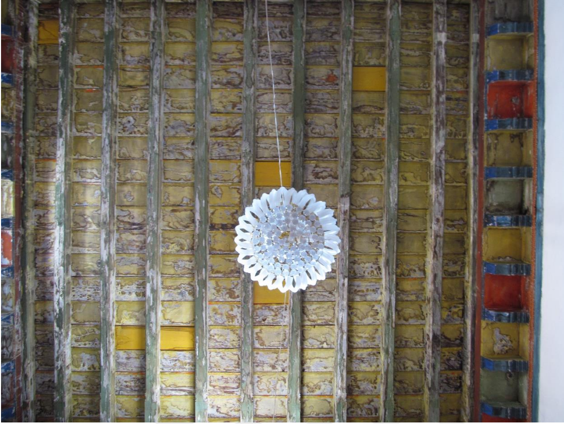
Şekil A.69 : Hızır Paşa İmaretî mescid eyvanı ahşap tavan örtüsü.
