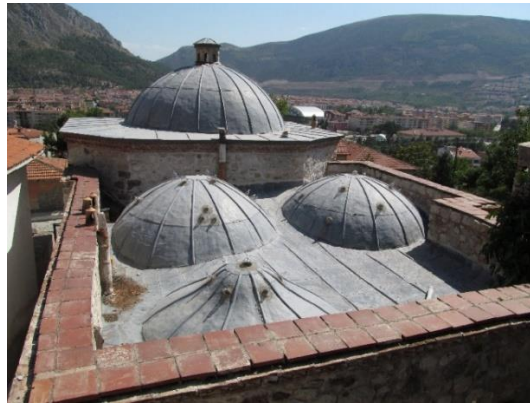
Şekil A.189 : Amasya Hızır Paşa Hamamı örtü sistemi.
