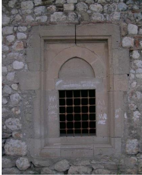
Şekil A.181 : Hızır Paşa Hamamı soyunmalık güney cephesi alt sıra pencere.
