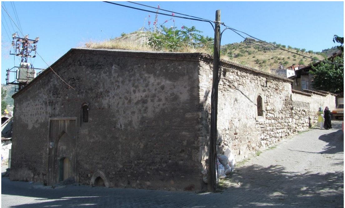
Şekil A.141 : Tokat Yörgüç Paşa Hamamı.
