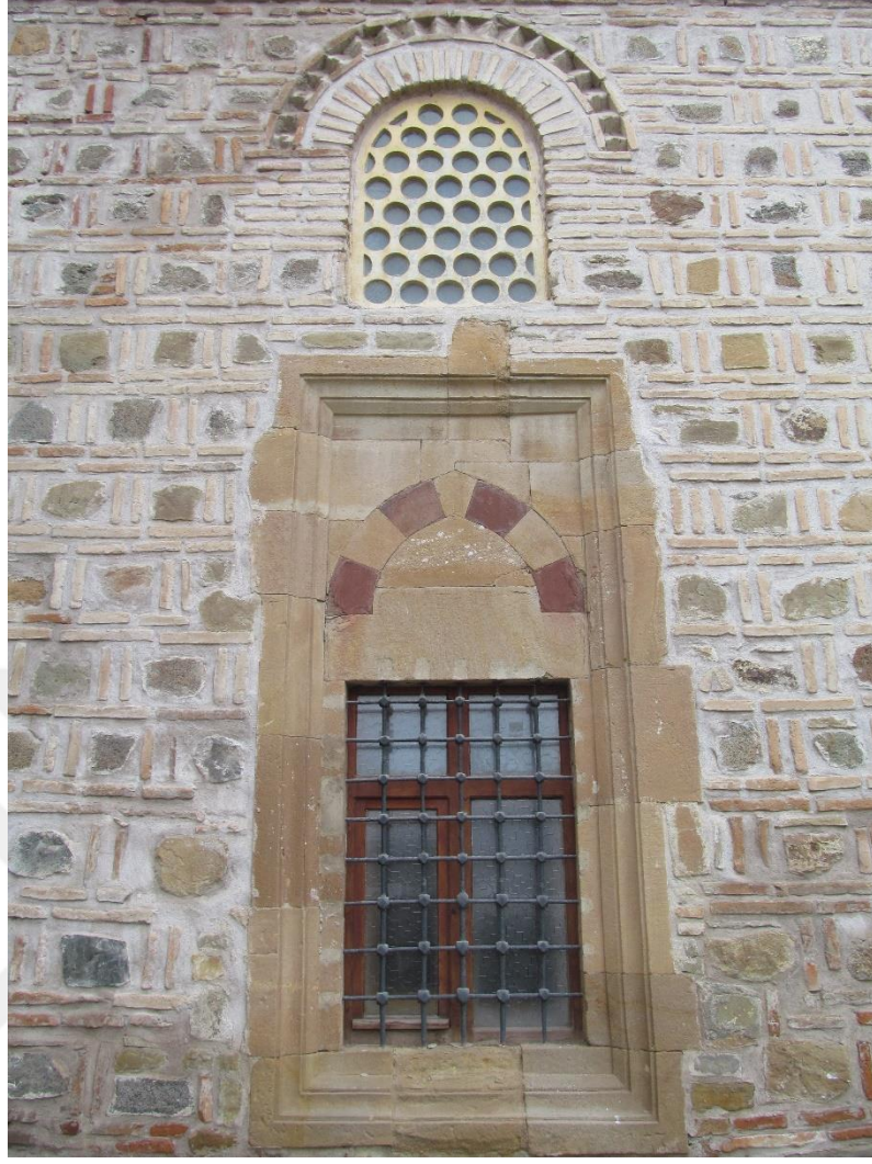
Şekil A.223 : Koca Mehmed Paşa İmaretî duvar örgüsü ve pencere düzeni.
