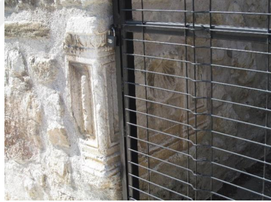
Şekil A.184 : Amasya Hızır Paşa Hamamı'nda devşirme malzeme.
