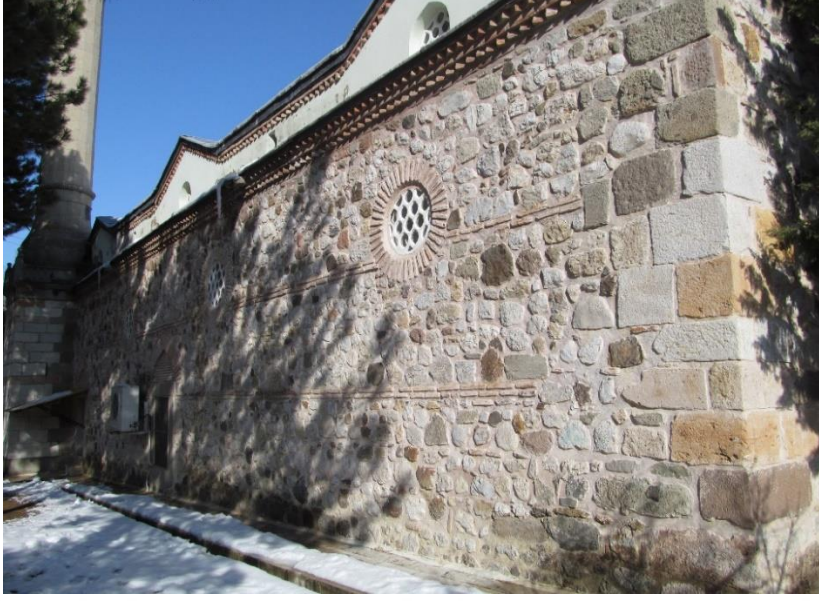
Şekil A.105 : Gümüş Yörgüç [Rüstem] Paşa Camisi batı cephesi.
