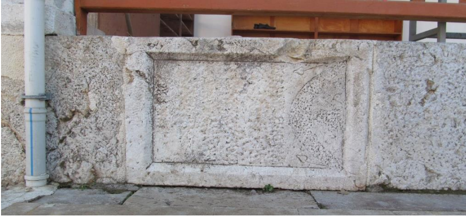
Şekil A.115 : Gümüş Yörgüç [Rüstem] Paşa Camisi'nde devşirme malzeme.
