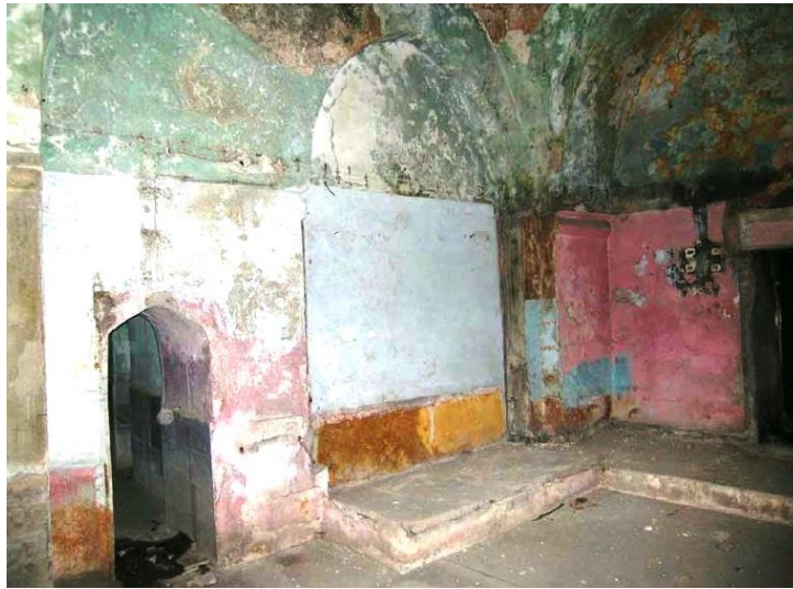
Şekil A.192 : Hızır Paşa Hamamı soyunmalık [kuzey ve doğu duvarı] (Oltulu).
