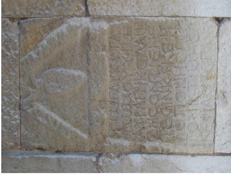
Şekil A.41 : Yörgüç Paşa İmareti duvar örgüsünde devşirme malzeme.
