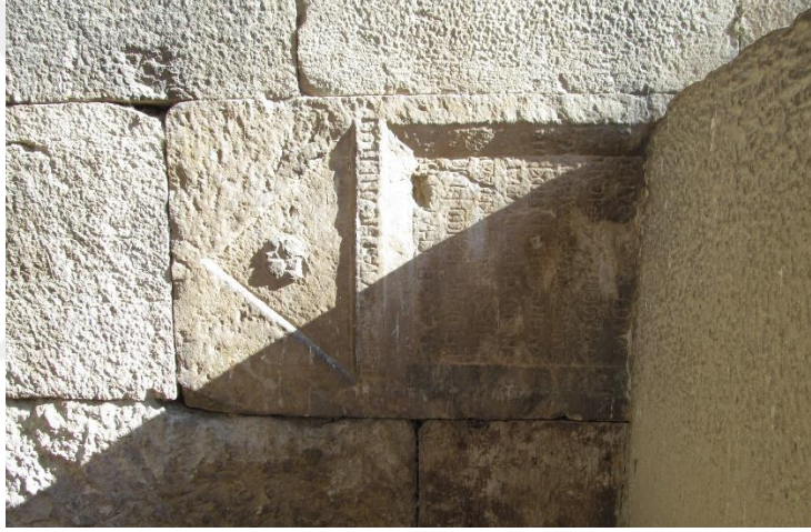
Şekil A.42 : Yörgüç Paşa İmareti duvar örgüsünde devşirme malzeme.
