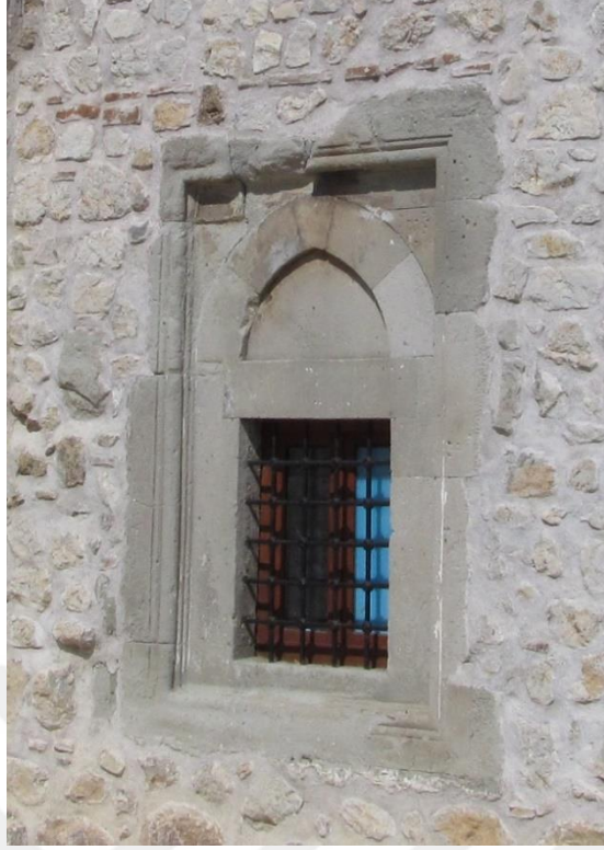
Şekil A.183 : Amasya Hızır Paşa Hamamı soyunmalık batı cephe pencere.
