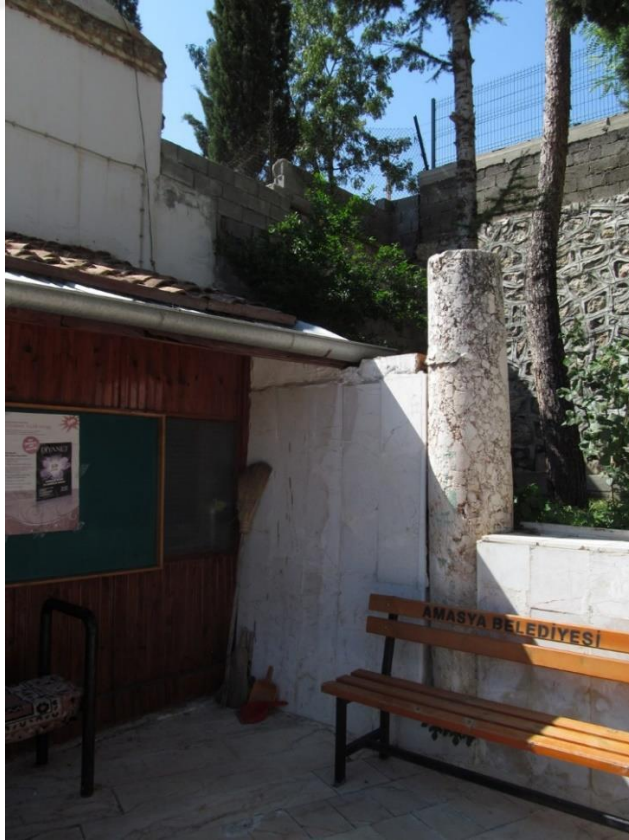
Şekil A.63 : Hızır Paşa İmareti medrese revâğı sütun kalıntısı.
