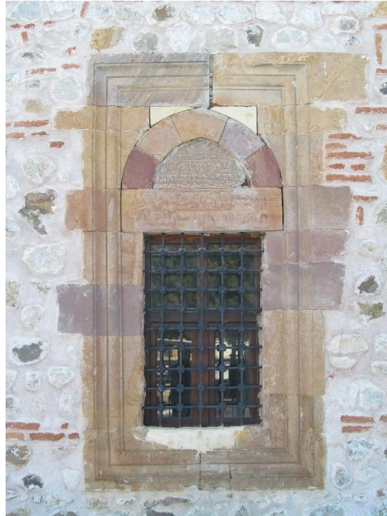
Şekil A.216 : Gümüş Haliliye Medresesi duvar örgüsü ve pencere düzeni.
