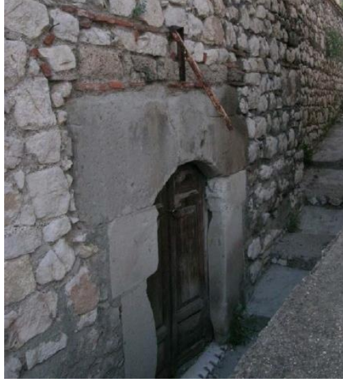
Şekil A.180 : Amasya Hızır Paşa Hamamı doğu cephesinde cümle kapısı.
