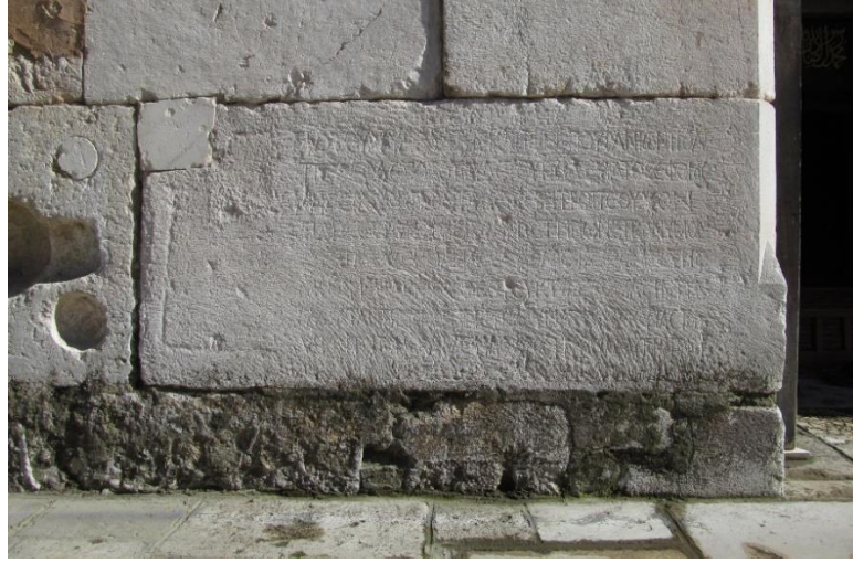
Şekil A.38 : Yörgüç Paşa İmareti kuzey cephesinde devşirme malzeme.
