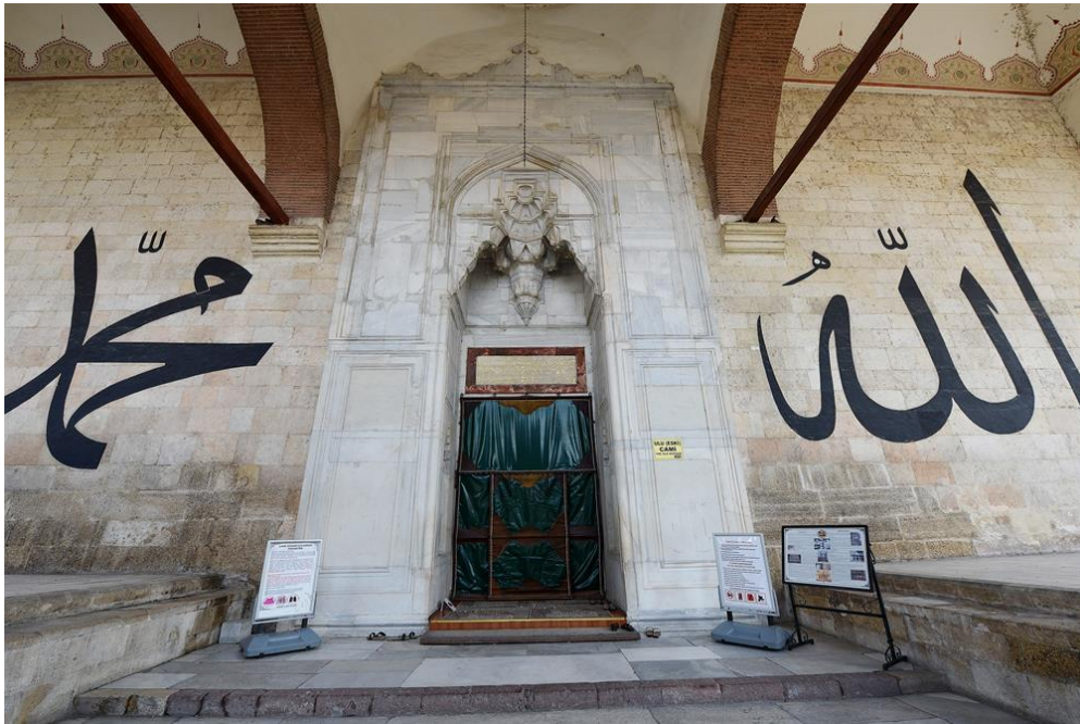
Şekil A.255 : Edirne Eski Cami kuzey giriş kapısı.
