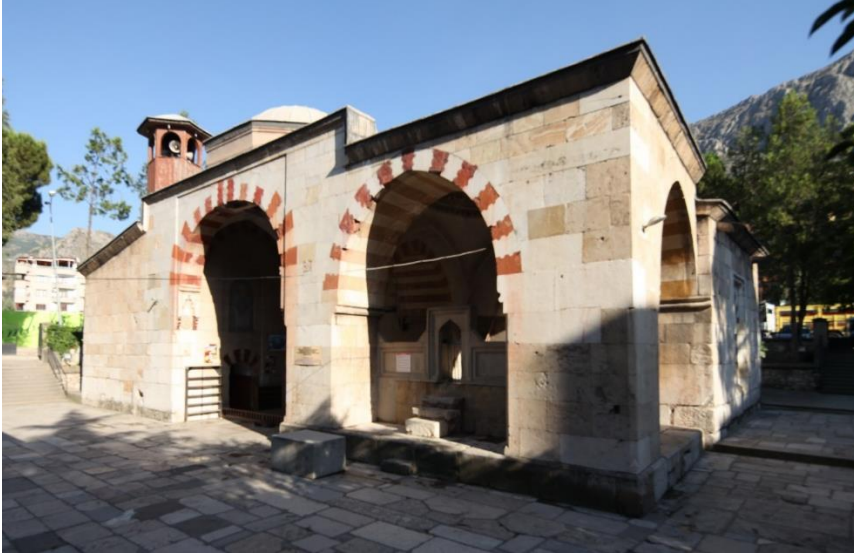
Şekil A.3 : Yörgüç Paşa İmareti, Yörgüç Paşa Türbesi (Aras Neftçi).
