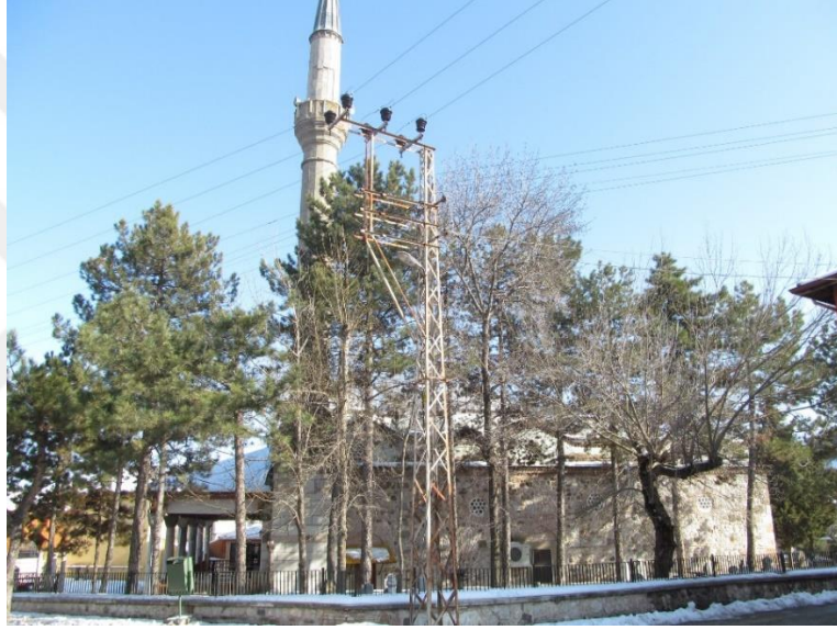
Şekil A.103 : Gümüş Yörgüç [Rüstem] Paşa Camisi batı cephesi
