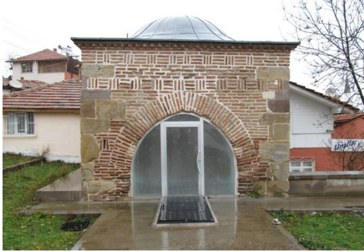
Şekil A.137 : Anonim Türbe batı cephesi son onarım sonrası.
