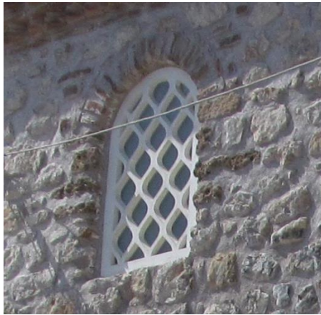
Şekil A.182 : Hızır Paşa Hamamı soyunmalık güney cephesi üst sıra pencere.
