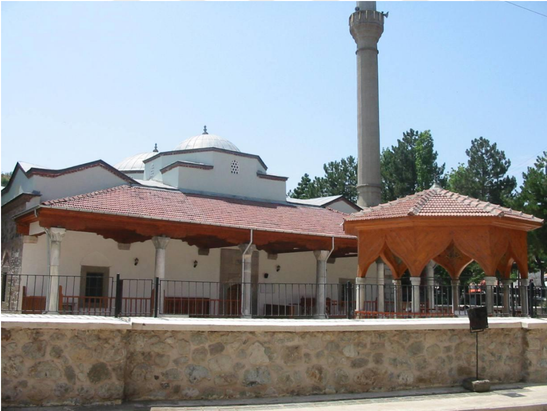
Şekil A.101 : Gümüş Yörgüç [Rüstem] Paşa Camisi.
