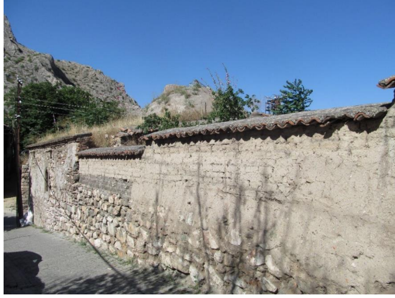
Şekil A.145 : Tokat Yörgüç Paşa Hamamı batı cephesi.
