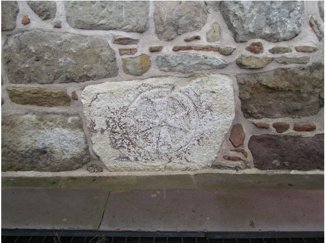
Şekil A.54 : Mustafa Bey İmaretî duvar örgüsünde devşirme malzeme.
