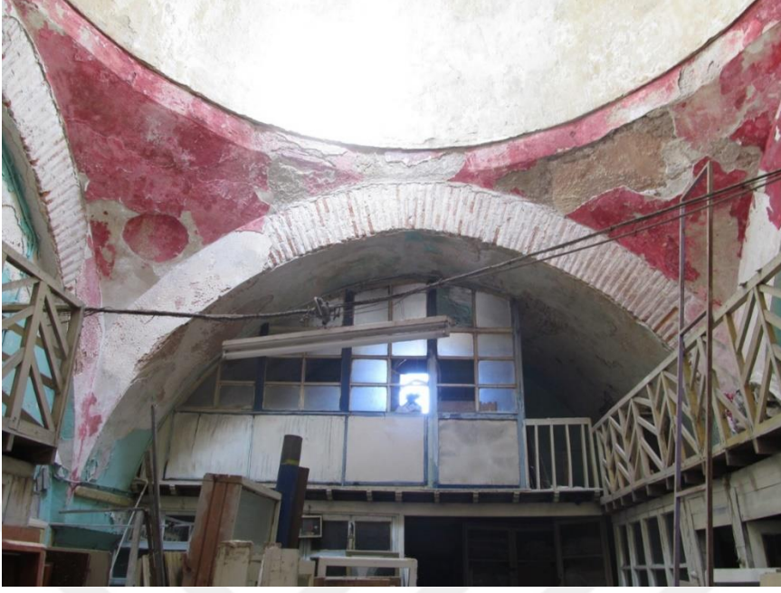
Şekil A.148 : Tokat Yörgüç Paşa Hamamı camekan [soyunmalık] bölümü.
