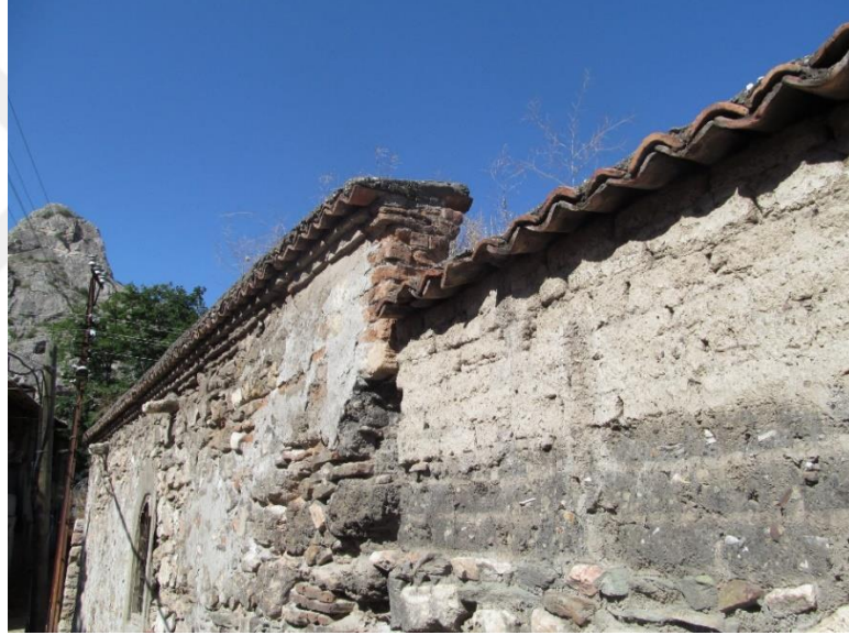
Şekil A.146 : Tokat Yörgüç Paşa Hamamı batı cephesi.
