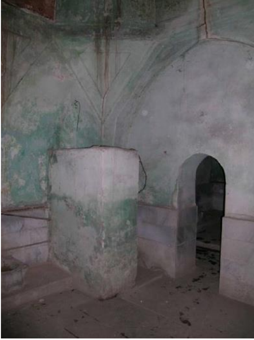
Şekil A.195 : Hızır Paşa Hamamı sıcaklık mekanı (Oltulu).
