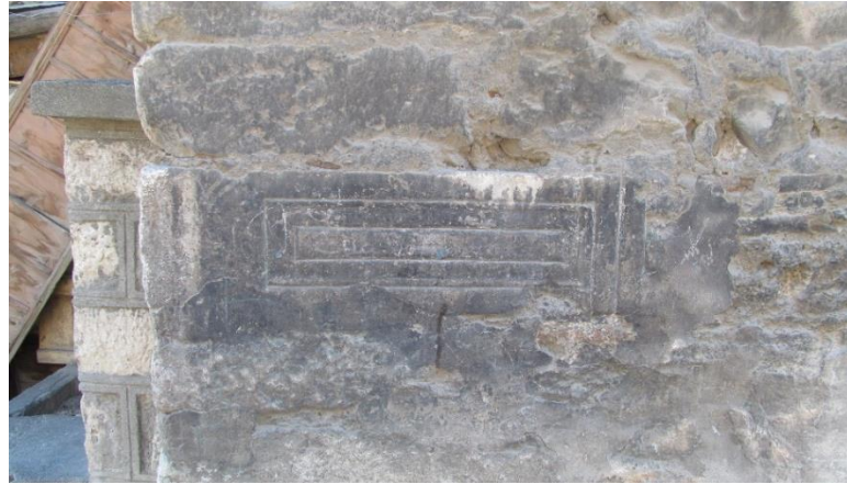
Şekil A.147 : Tokat Yörgüç Paşa Hamamı duvar örgüsünde devşirme malzeme.
