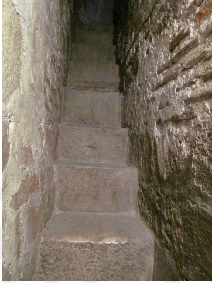
Şekil A.20 : Yörgüç Paşa İmareti çatıya çıkan merdiven.
