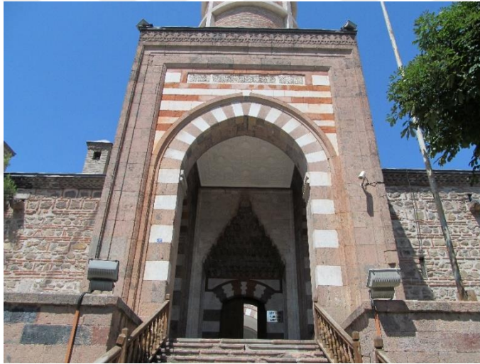
Şekil A.210 : Merzifon Çelebi Sultan Mehmed Medresesi cümle kapısı ve kitabe.
