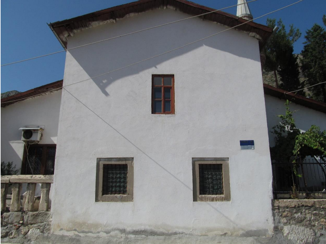
Şekil A.56 : Hızır Paşa İmareti güney cephesi.
