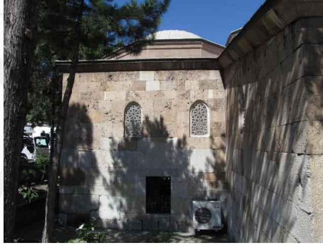
Şekil A.28 : Yörgüç Paşa İmareti mescid eyvanı doğu cephesi.
