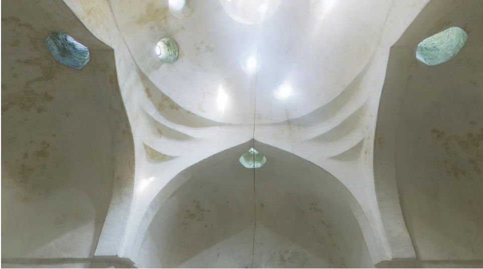
Şekil A.167 : Mustafa Bey Hamamı ikinci [batı] sıcaklık örtü sistemi.
