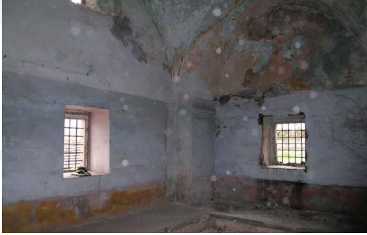
Şekil A.191 : Hızır Paşa Hamamı soyunmalık [güney ve batı duvarı] (Oltulu).
