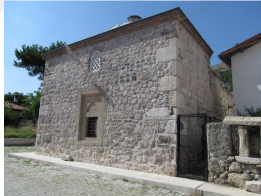
Şekil A.188 : Amasya Hızır Paşa Hamamı güney cephesi.
