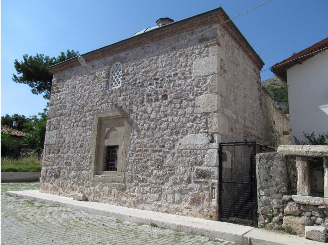
Şekil A.179 : Amasya Hızır Paşa Hamamı güney cephesi.
