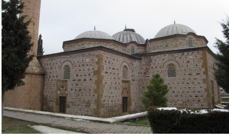
Şekil A.221 : Osmancık Koca Mehmed Paşa İmaretı batı cephesi.
