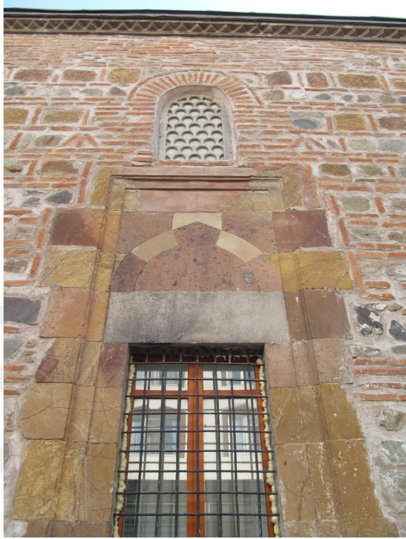
Şekil A.212 : Çelebi Sultan Mehmed Medresesi duvar örgüsü ve pencere düzeni.
