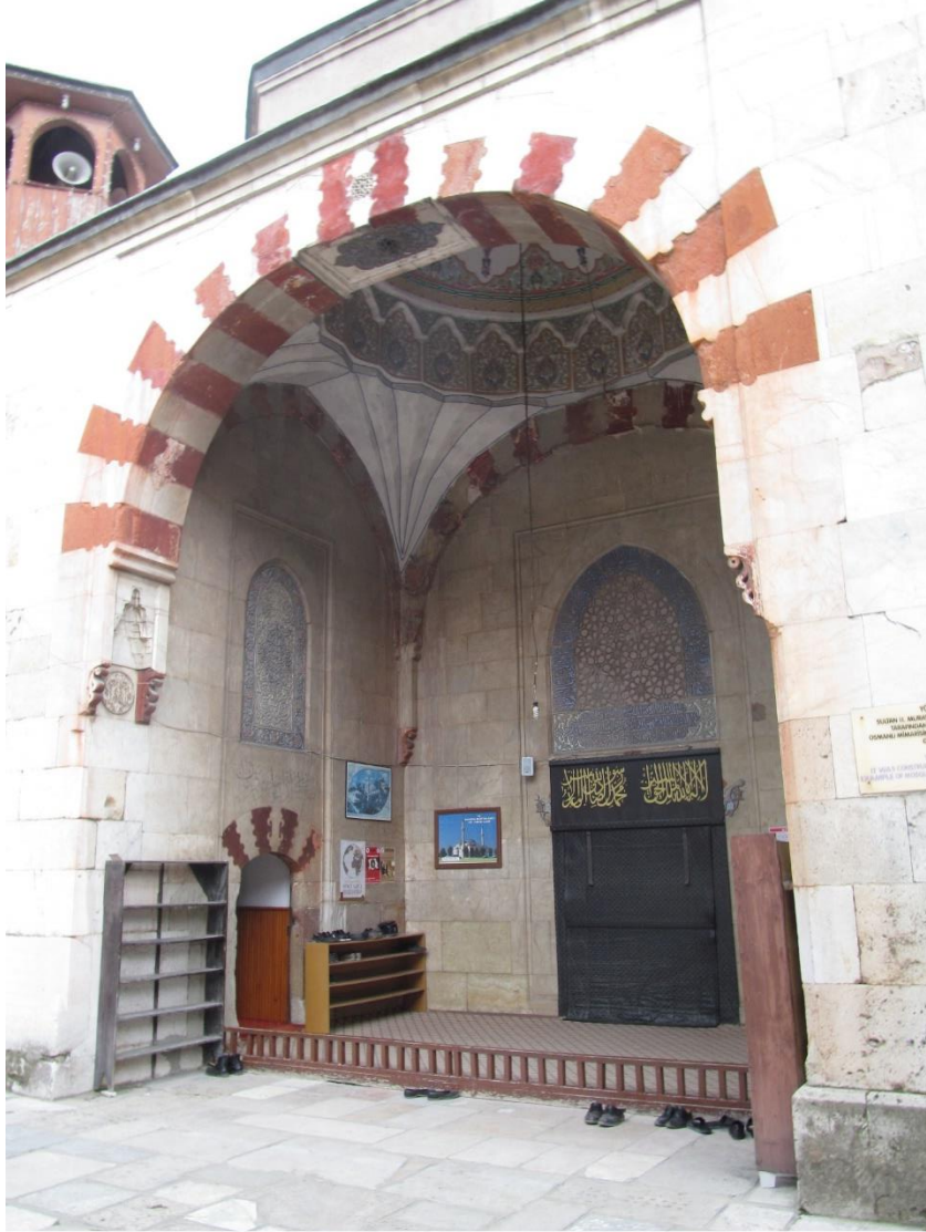
Şekil A.4 : Yörgüç Paşa İmareti giriş eyvanı.
