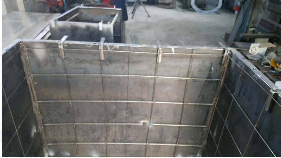
Fotoğraf 2.20. Donatı montajı
