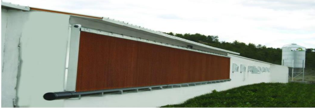
Şekil 3.4. Tüplü pet panel sistemi
