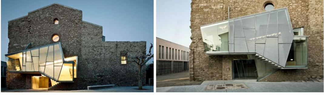
Resim 3.29 İspanya'nın Katalan kasabası Santpedor'daki Sant Francesc Kilisesi, Çok İşlevli kültür merkezi/Oditoryum ,Yeni Giriş Kapsı, Gece ve gündüz Görünüm (URL-43, 2016)
