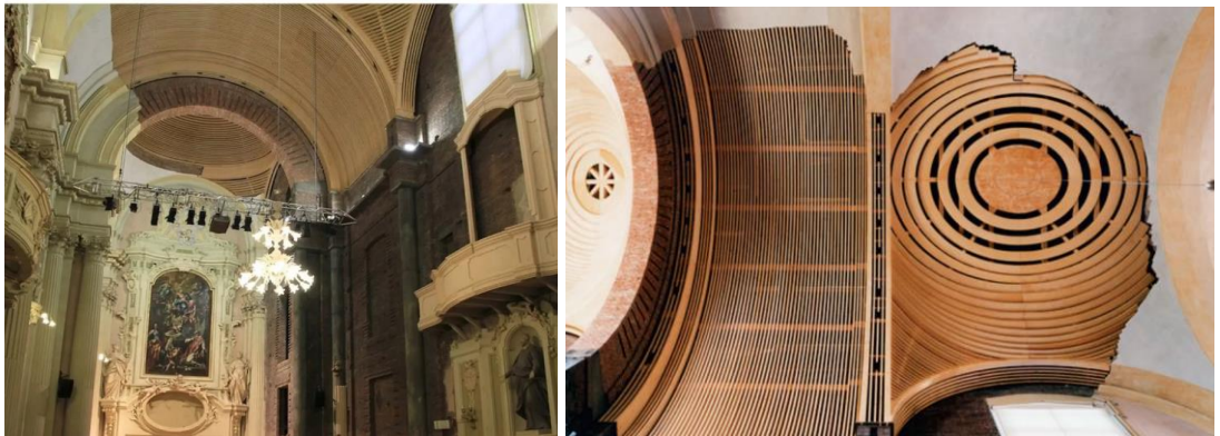
Resim 3.14 “Oratorio Dei Filippini” Kilisesinin Şavaşta Yıkılmış Olan Tonoz Ve Kubbesinin Yaratıcı Restorasyonu. (Şavaşın ve yıkımın unutulmamasını istemiş olan tasarımcı, eski yapım sistemiyle tonoz ve kubbenin iskeletini oluşturmuş sonrasında sıvamayarak hem modern görünüm elde etmiş hem de ilk yapılış dönemi ile savaş dönemindeki yıkım arasında bir diyalog kurmuştur ) (URL-30, 2016)
