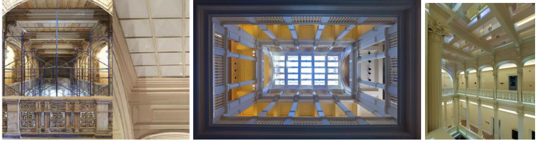
Resim 3.20 19.yy'da Alexandre Vallury'ın Tasarladığı Osmanlı Bankası Binası. "Salt Beyoğlu" . Orta Galerî Boşluğu ve Suni Güneşliği Sağlayan Yeni Çatısı (Dinç, E.B., 2012)
