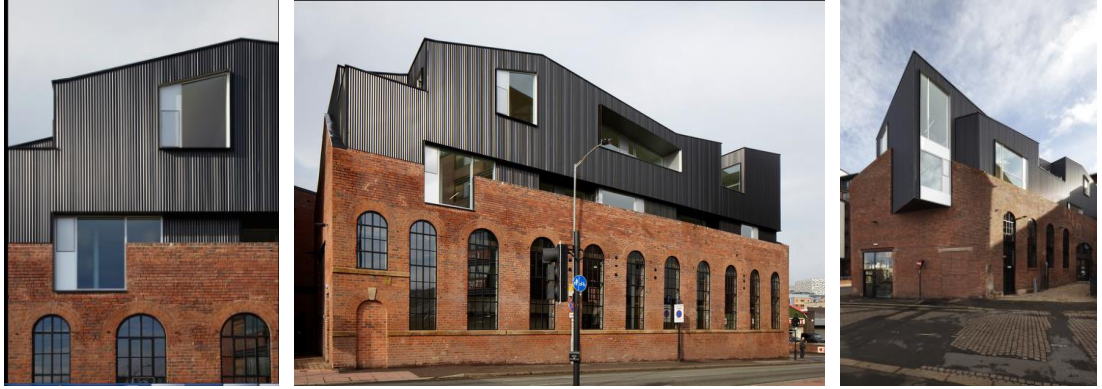
Resim 3.51 Sheffield Shoreham'da Kırmızı Tuğladan Yapılmış Olan Viktorya Dönemine Ait Bir Endüstri Yapısı Siyah Metal Plaklarla Yükseltilmiş Ek Çatı Yapısı (URL-70, 2016)
