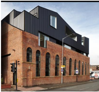
Resim 3.61 Sheffield Shoreham'da Kırmızı Tuğladan Yapılmış Olan Viktorya Dönemine Ait Bir Endüstri Yapısı Siyah Metal Plaklarla Yükseltilmiş Ek Çatı Yapısı (URL-70, 2016)
