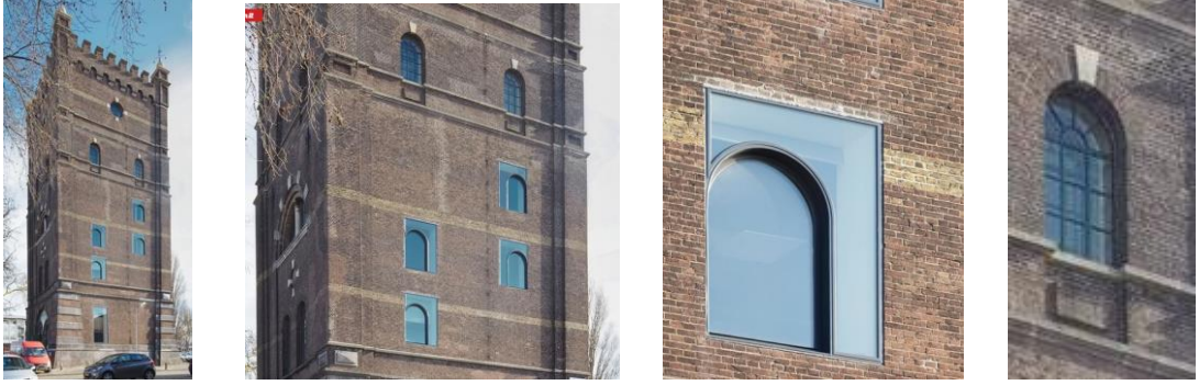
Resim 3.23 Den Bosch / Hollanda'nın Den Bosch Şehrini Kapsı Olarak Bilinen Eski Su Kulesi – Ofis Mekanı . Yeni Açılan Pencere Boşlukları Ve Doğramalar (URL-37, 2016)
