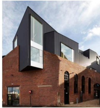
Resim 3.61 Sheffield Shoreham'da Kırmızı Tuğladan Yapılmış Olan Viktorya Dönemine Ait Bir Endüstri Yapısı Siyah Metal Plaklarla Yükseltilmiş Ek Çatı Yapısı (URL-70, 2016)
