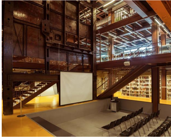
Resim 3.3 Silahtarağa Elektrik Santrali, Kütüphane Ve Mimarlık Fakültesi Haline Çevrilen 4 Ve 6 Nolu Kazan Dairelerindeki, Proje Sunum Alanı. (URL-15, 2016)
