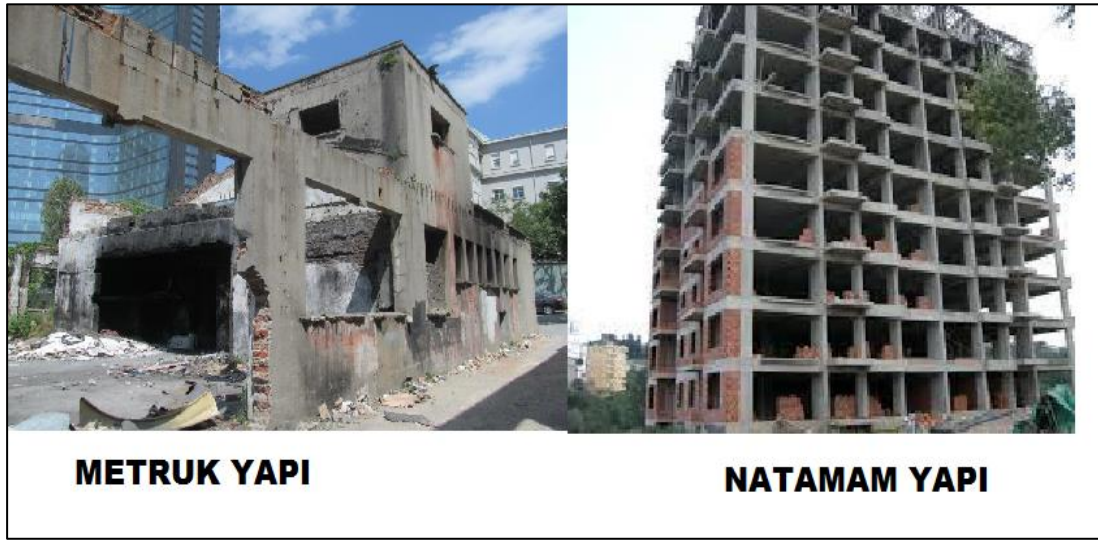
Şekil 4.1 : Metruk ve natamam yapı örneği (Çevre ve Şehircilik Bakanlığı, Alt Yapı ve Kentsel Dönüşüm Hizmetleri Genel Müdürlüğü, Riskli Yapılar Dairesi Başkanlığı, ty).
