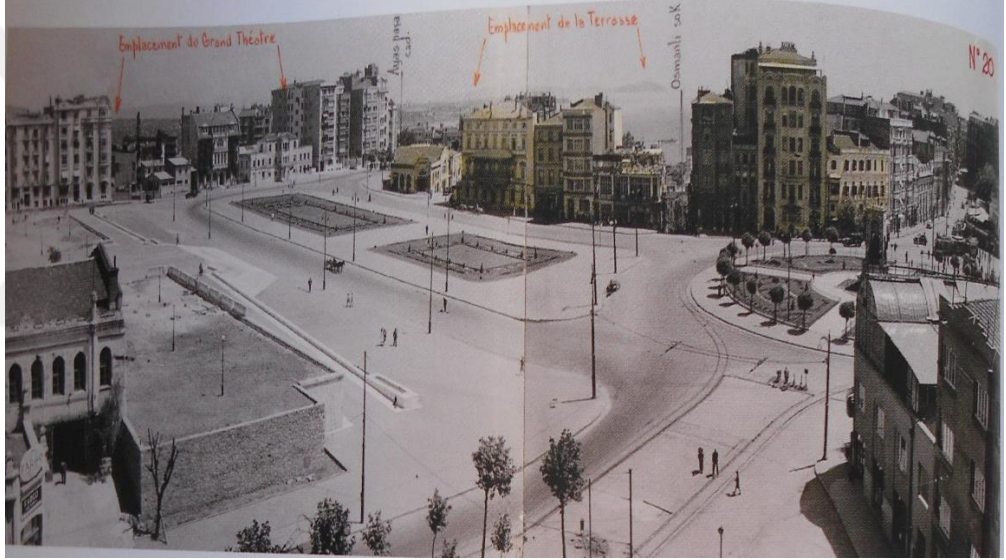
Fotoğraf 9: Taksim Meydanı Genel Görünüşü-14 Temmuz 1941 (AKM büyük tiyatronun yerleşimi için öngörülen işlemler not alınmış)
