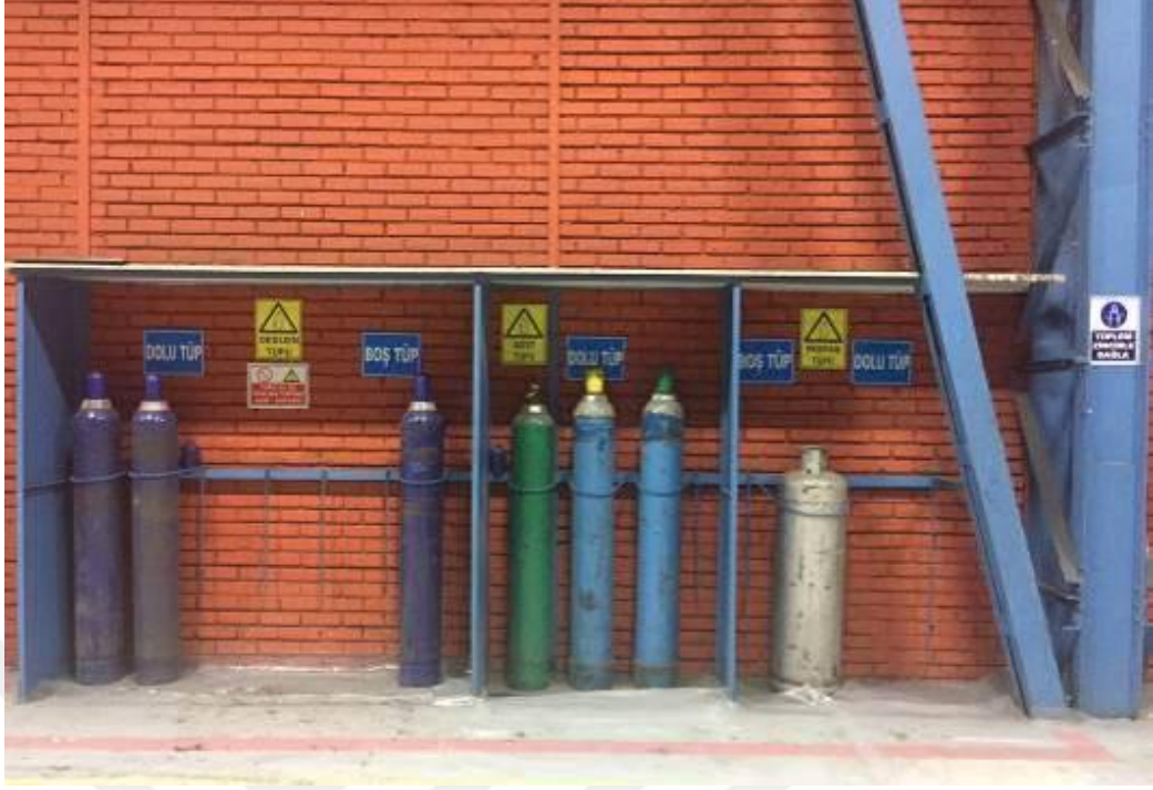
Şekil 5.19. Tüplerin muhafazalı ortama konulması ve zincirle sabitlenmesi görüntüsü.
