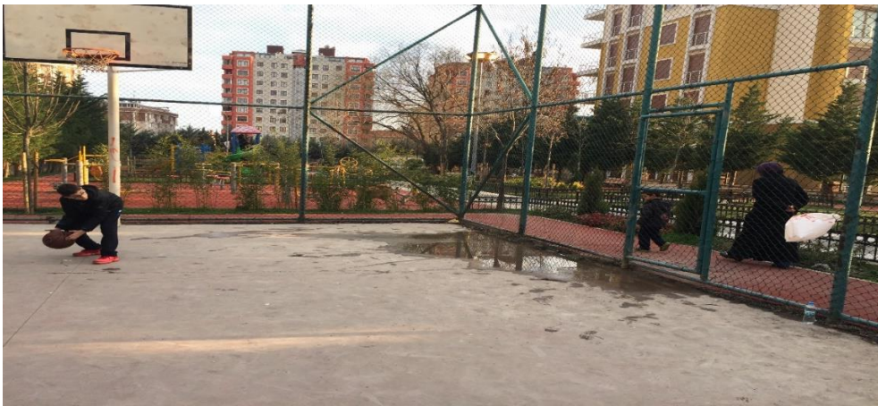
Şekil 4.14 : Basketbol sahasında suyun birikmesi.
