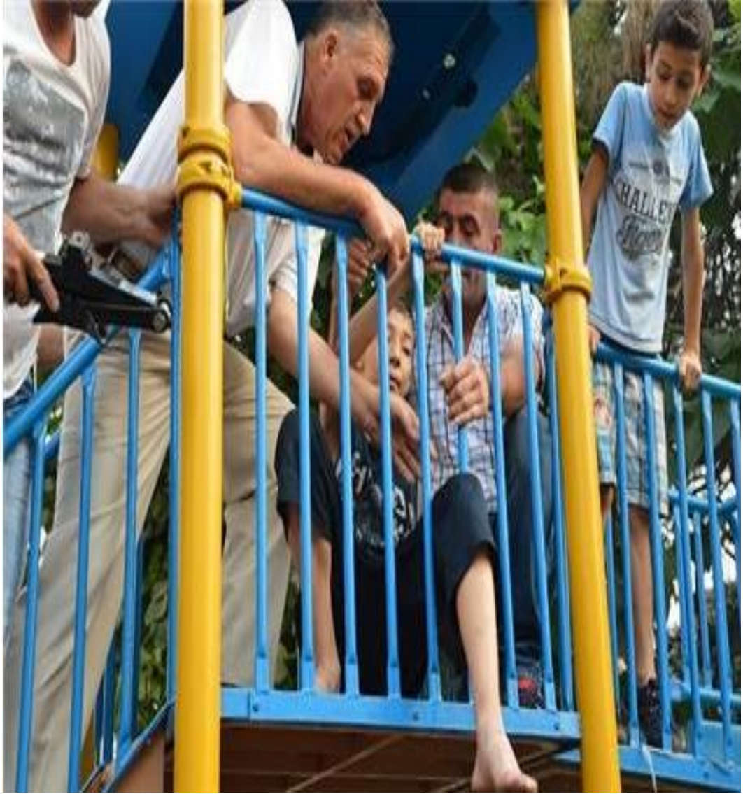
Şekil 4.4 : Dört tarafı kapalı boşluk koşulunu sağlamayan oyun elemanı (Url-25).
