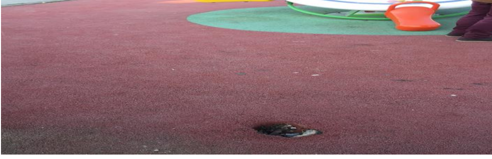
Şekil 4.13 : Zemin yüzeyinde delik açılan çocuk oyun alanı örneği.
