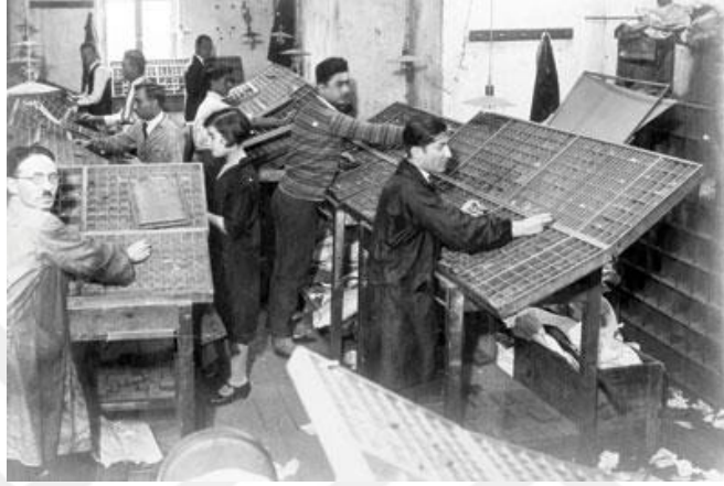
Cumhuriyet'in ilanını takip eden yıllarda harf tezgâhları başında yazı dizen mürettepler. 52
