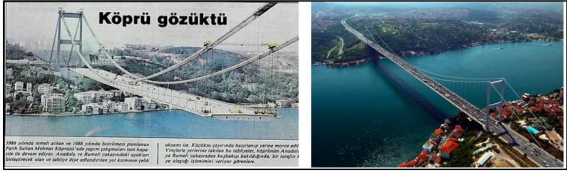
Şekil 4.16 : FSM Köprüsü'nün inşaatını gösteren bir gazete haberi (Url-19).
