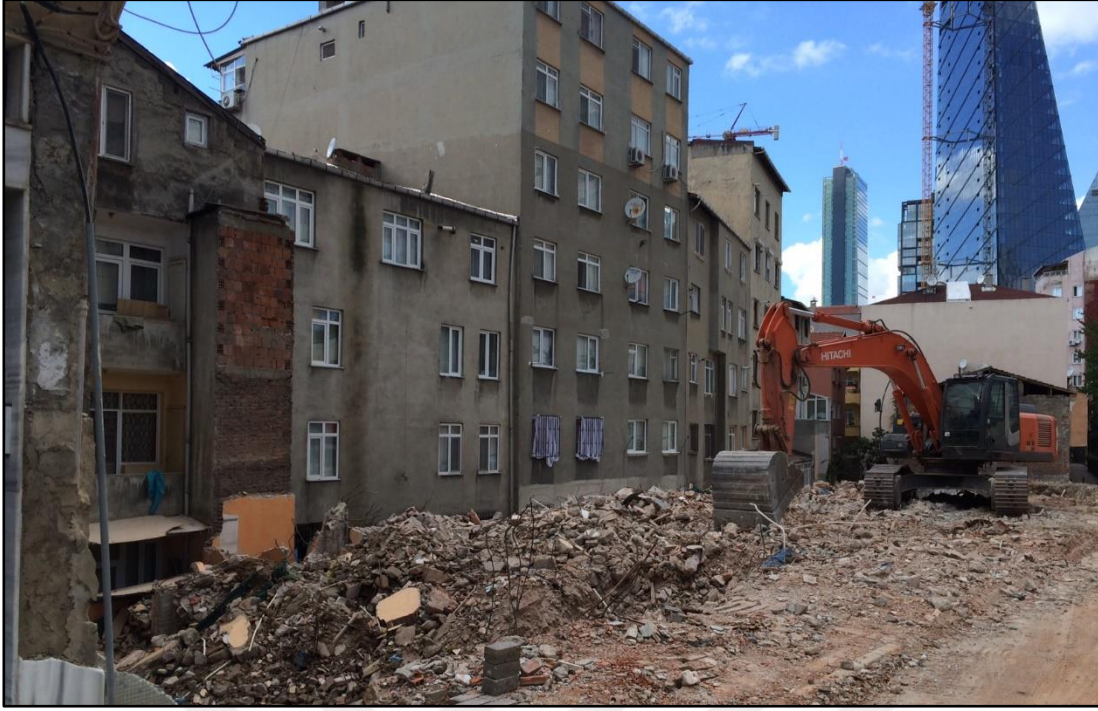
Şekil 4.30 : Levent Gate proje alanındaki yapılar yıkıldıktan sonraki hali (Büşra Başkurt Arşivi, 2017).
