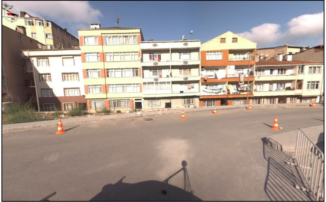
Şekil 4.29 : Levent Gate proje alanındaki yapılar yıkılmadan önceki konut cephesi (Büşra Başkurt Arşivi, 2017).
