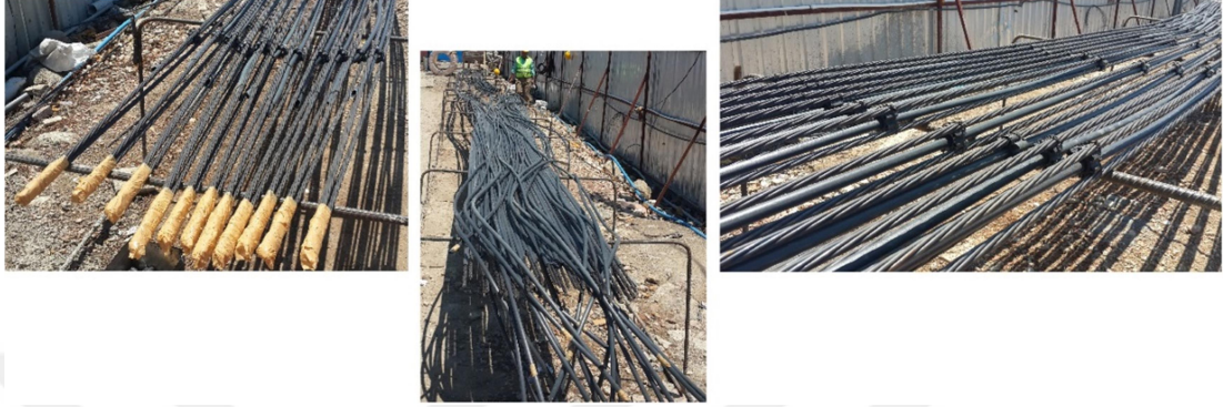
Şekil 3.9 : İmalata hazırlanan ankraj demetleri.
