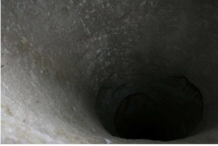
Resim 4.4. Derinkuyu yeraltı şehri, havalandırma bacasının görünüşü (Okuyucu, 2007)
