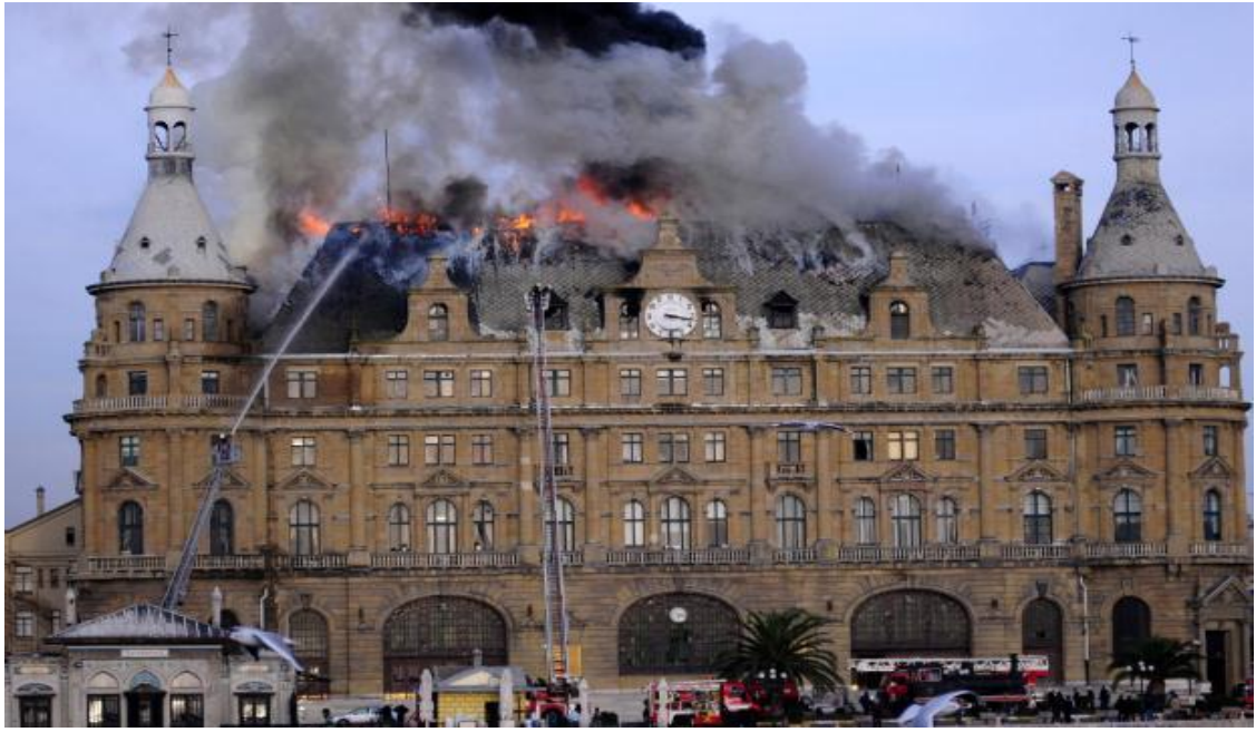
Şekil 2.6. Haydarpaşa Gar binası yangını (Serbest, 2013)
