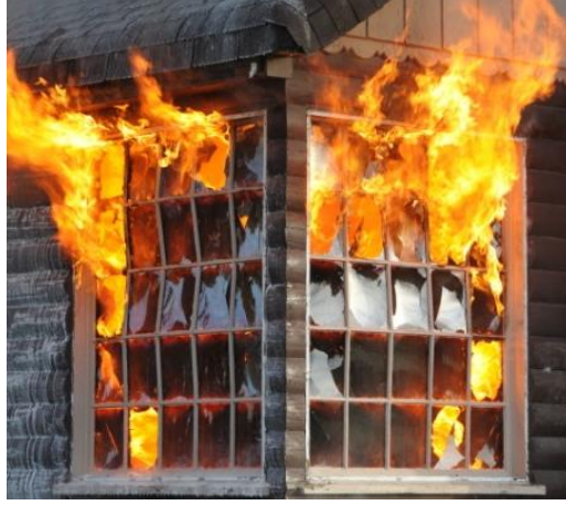
Şekil 5.3. Yangında patlayan camlar (Jenkins, 2008)
