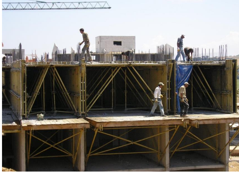
Şekil 1.18. Tünel Kalıp Destek Elemanları
