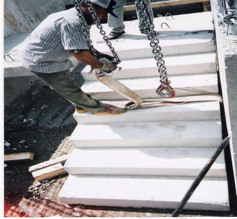
Şekil 1.21. Tünel Kalıp Sisteminde Merdivenin yerleştirilmesi.
