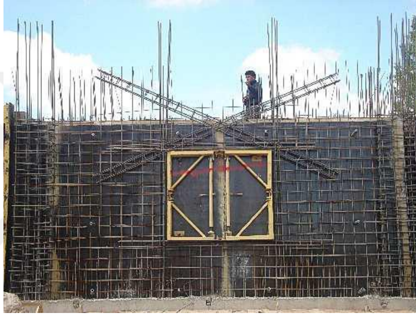
Şekil 1.20. Tünel Kalıp Sisteminde Pencere Boşluğunun Bırakılması.
