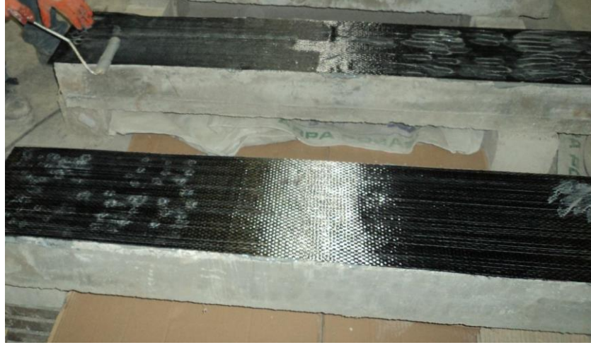
Şekil1.1 CFRP kumaş ile kiriş güçlendirme uygulaması
