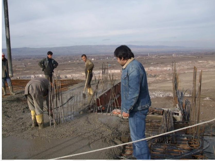
Şekil 1.23 Tünel Kalıp Sisteminde Beton Yerleştirilmesi.
