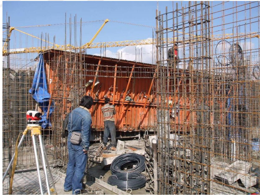
Şekil 1.19. Tünel Kalıp Sisteminde Kalıbın Yerleştirilmesi
