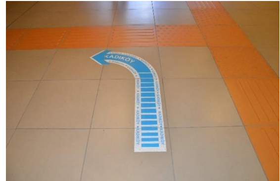
Şekil 5.90 Kartal İstasyonu, kılavuz yol, uyarıcı yol
