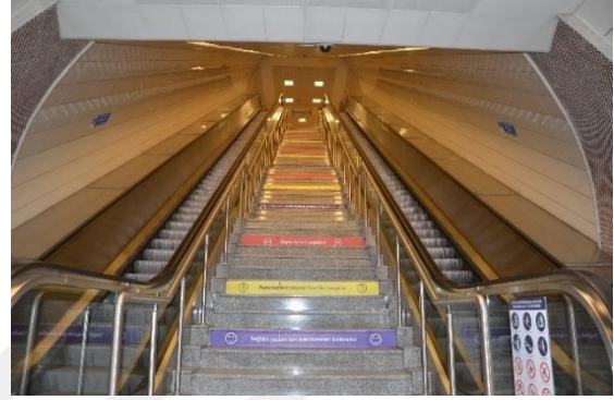
Şekil 5.92 Kartal İstasyonu, merdiven tüneli duvar kaplaması
