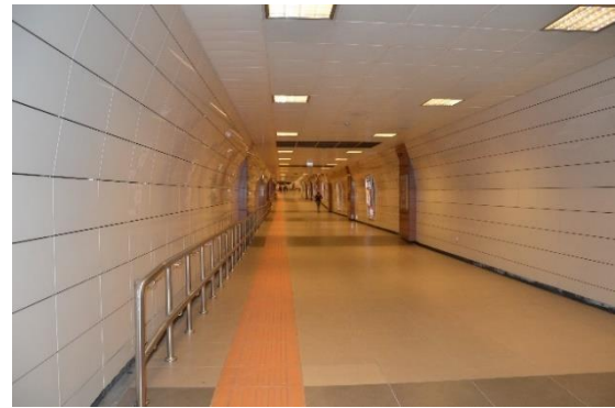
Şekil 5.75 Kartal İstasyonu, rampa
