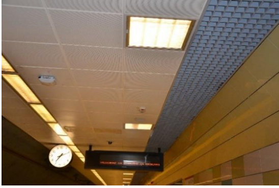
Şekil 5.32 Kadıköy İstasyonu, peron aydınlatması
