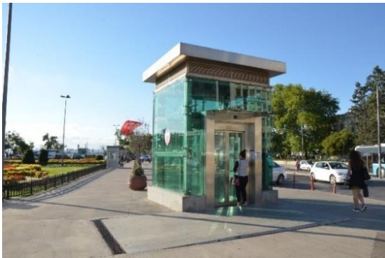
Şekil 5.9 Kadıköy İstasyonu, asansör önünde ızgara düzenlemesi
