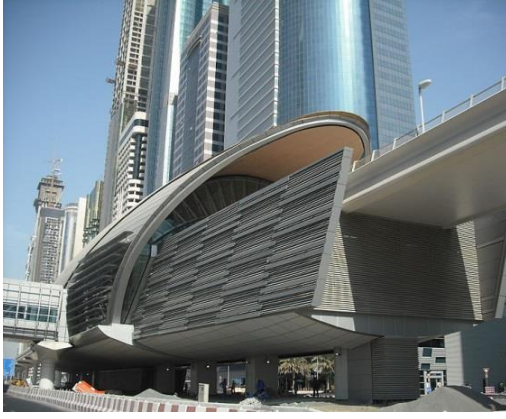
Şekil 2.11 Yükseltilmiş yer üstü metro istasyonu örneği: Dubai Mall of Emirates İstasyonu [21]
