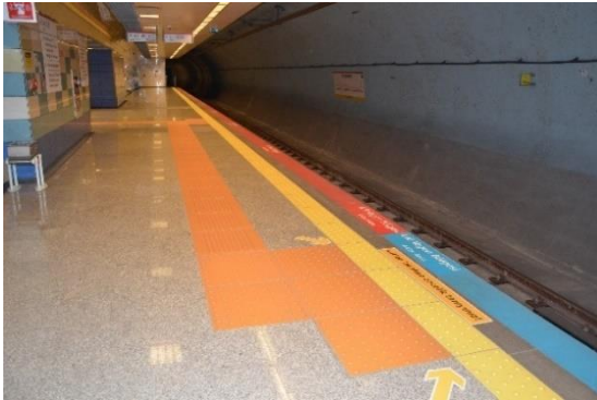
Şekil 5.27 Kadıköy İstasyonu, peron katı zemin kaplama malzemesi
