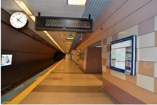
Şekil 5.83 Kartal İstasyonu, peronda bulunan elektronik pano
