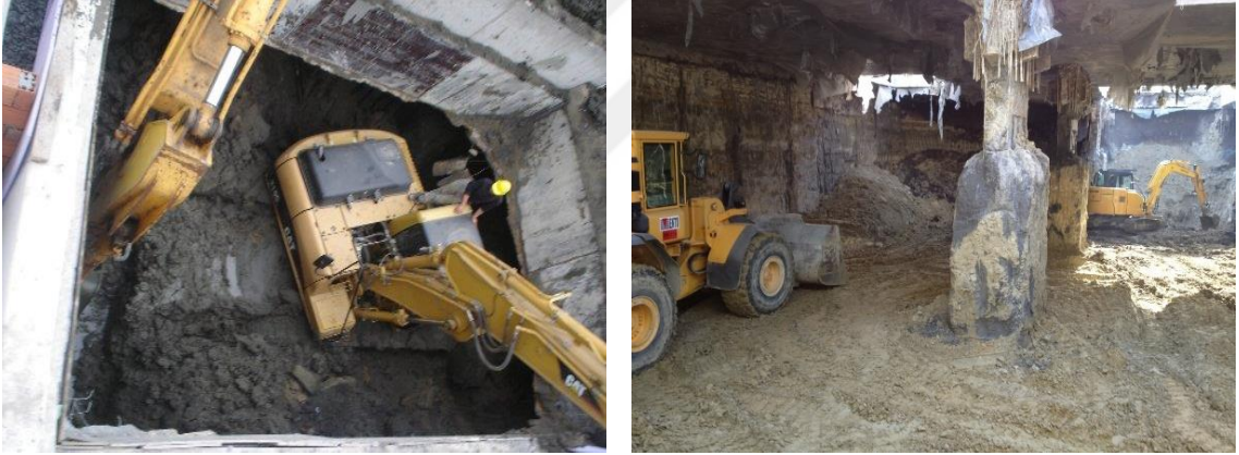
Şekil 3.7 Top-down yönteminde yapının içindeki toprağın kazılması [15]
