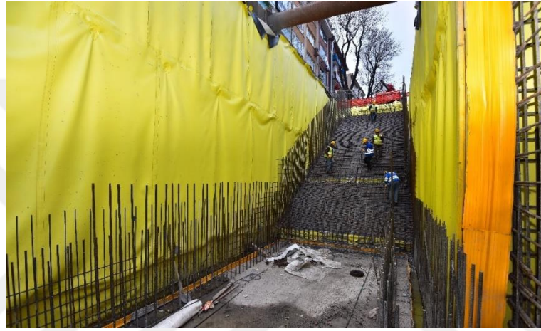
Şekil 4.1 İstasyon giriş yapısındaki yalıtım uygulaması örneği [15]
