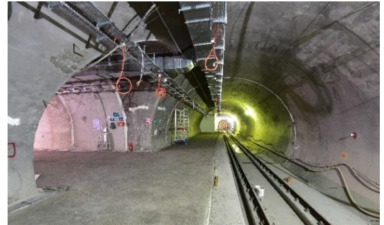
Şekil 4.28 Yer altı metro istasyonlarındaki mekanik havalandırma kanalları [15]
