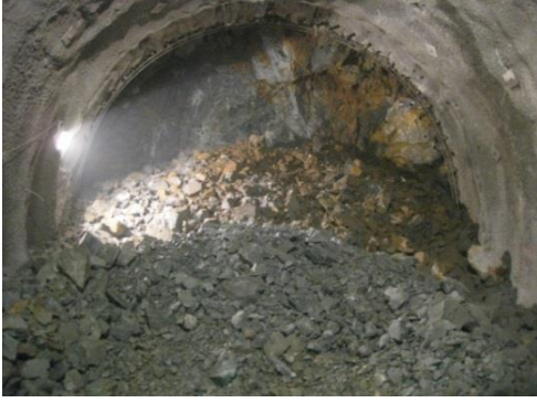
Şekil 2.7 Delme-patlatma sonrası tünel aynasının görünümü [15]
