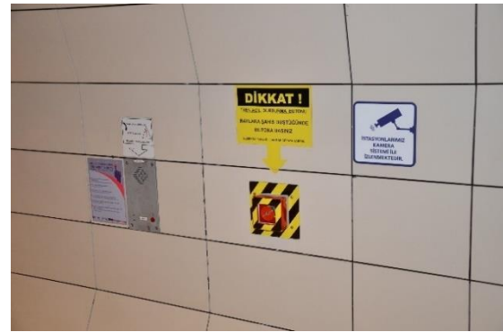
Şekil 5.82 Kartal İstasyonu, peron katında bulunan diafon ve acil durum butonu
