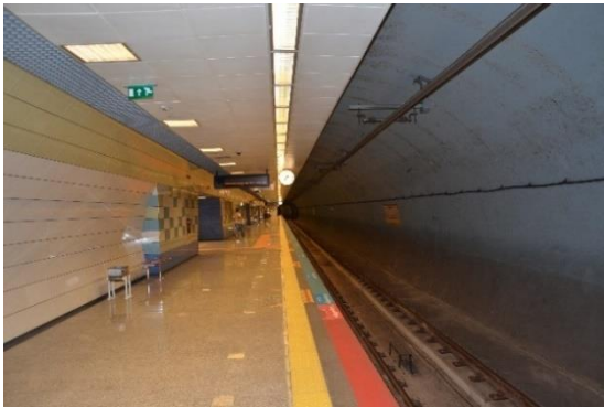
Şekil 5.21 Kadıköy İstasyonu, peron katı
