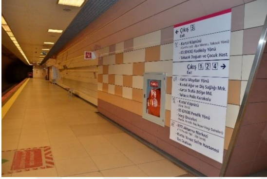
Şekil 5.91 Kartal İstasyonu, peron katı duvar kaplaması
