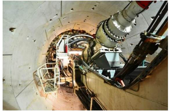
Şekil 2.10 TBM’in tüneldeki görüntüsü [16]
