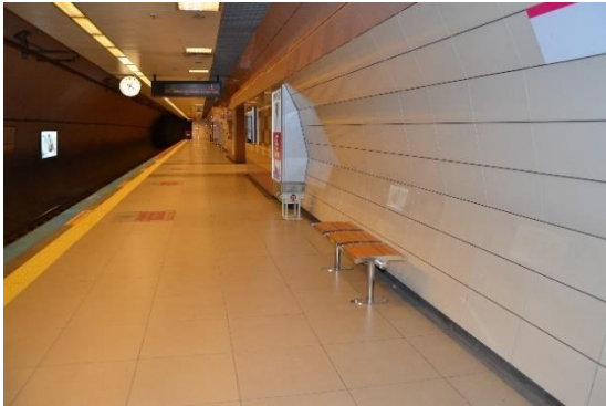
Şekil 5.89 Kartal İstasyonu, peron katı duvar dibi “U” biçiminde kanal uygulaması
