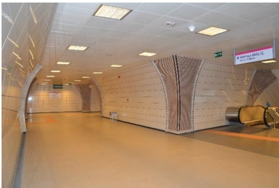
Şekil 5.93 Kartal İstasyonu, birleşim noktaları mozaik doğal taş uygulaması
