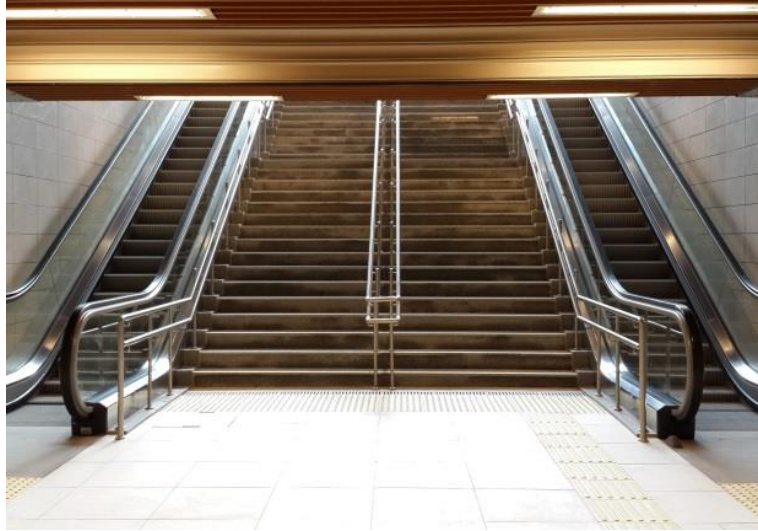
Şekil 3.27 Sabit merdiven örneği: Kadıköy-Kaynarca/Tavşantepe Metro Hattı, Ünalın istasyonu
