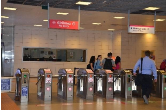
Şekil 5.87 Kartal İstasyonu, istasyon işletme odası
