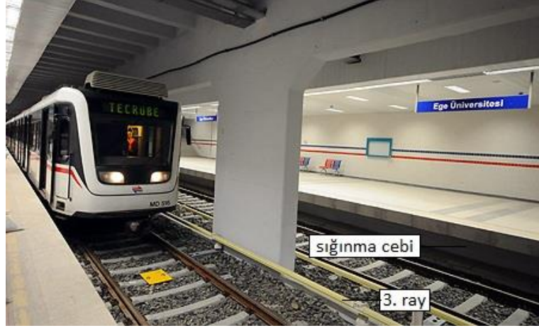
Şekil 4.2 Sığınma cebi ve 3. ray görünümü: İzmir, Ege Üniversitesi İstasyonu [79]
