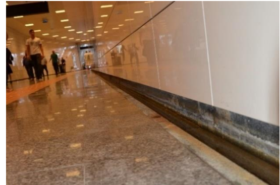
Şekil 5.28 Kadıköy İstasyonu, duvar dibi “U” biçiminde kanal uygulaması
