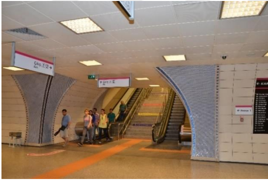
Şekil 5.30 Kadıköy İstasyonu, birleşim noktaları mozaik doğal taş uygulaması
