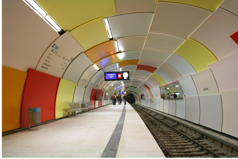
Şekil 4.16 Tünel yapım yöntemi ile yapılan peron: Almanya, Münih, Garching İstasyonu [124]
