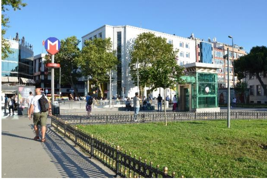
Şekil 5.7 Kadıköy İstasyonu, 3 nolu giriş
