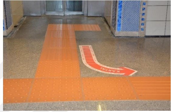
Şekil 5.37 Kadıköy İstasyonu, zeminde bulunan yönlendirme okları
