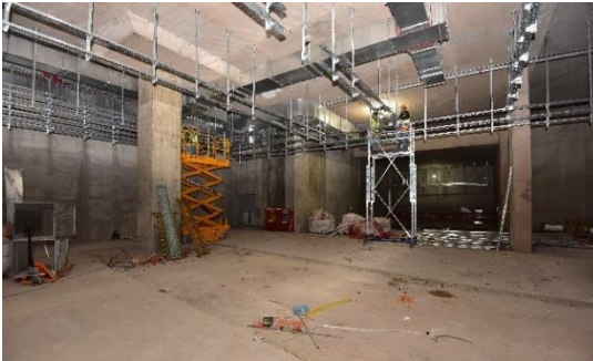
Şekil 4.28 Yer altı metro istasyonlarındaki mekanik havalandırma kanalları [15]
