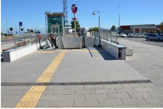
Şekil 5.70 Kartal İstasyonu, girişte ızgara düzenlemesi
