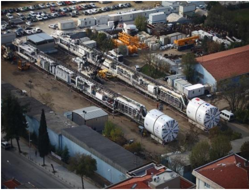
Şekil 2.9 TBM’in yüzeydeki görüntüsü [15]
