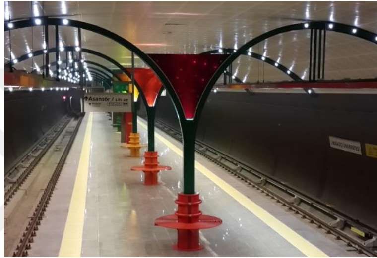
Şekil 4.30 Peron kenarı uyarıcı emniyet bandı örneği: Boğaziçi İstasyonu
