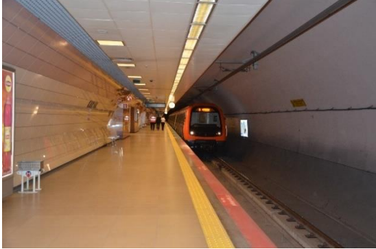
Şekil 5.95 Kartal İstasyonu, peron aydınlatması
