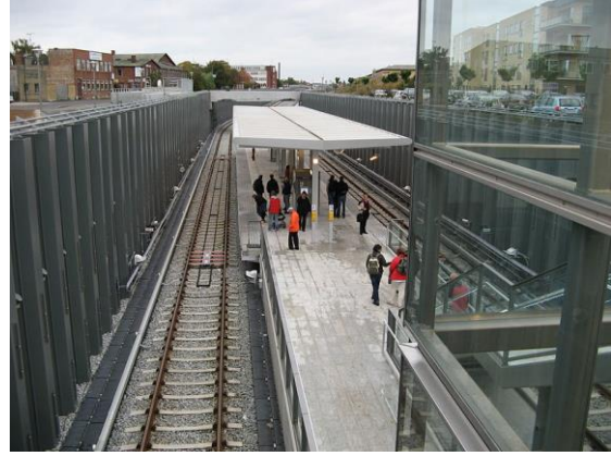
Şekil 2.12 Hemzemin yer üstü metro istasyonu örneği: Danimarka Kopenhag, Qresund İstasyonu [22]
