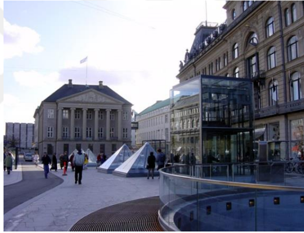
Şekil 4.4 Danimarka, Copenhagen metrosu, yüzeyden doğal ışık almak için kullanılan prizmalar [89]
