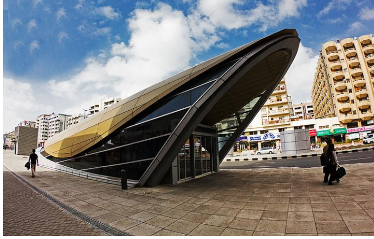
Şekil 3.19 Dubai metrosu girişi [40]
