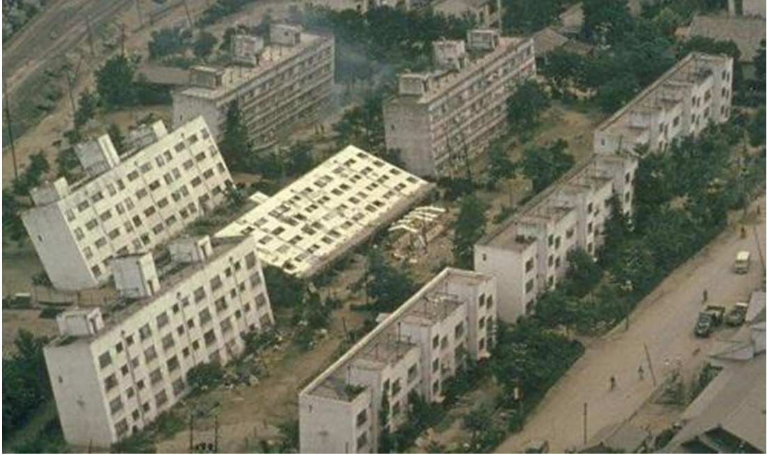
Şekil 4.1: Niigata depremi sonrası sıvılaşma etkisiyle zarar gören yapılar (Japan National Committee on Earthquake Engineering 1965).
