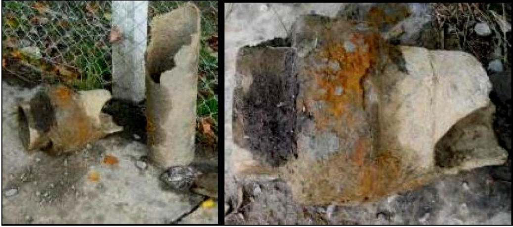
c) Dökme Demir Boruda Kırılma
