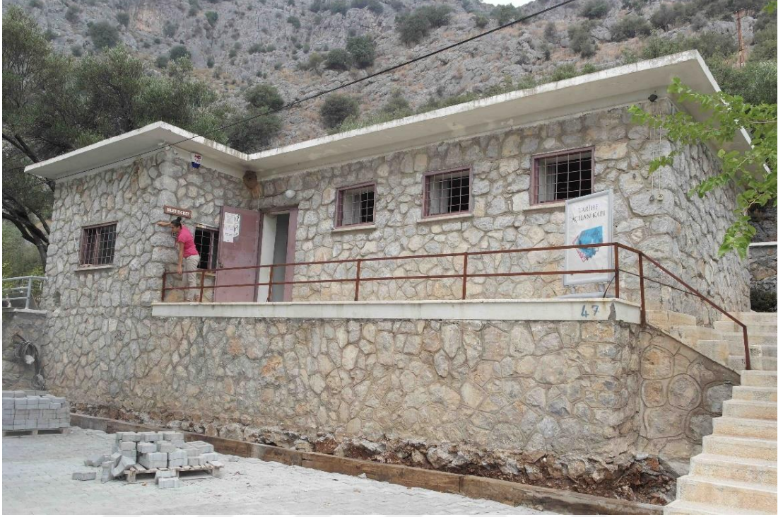
Resim 77: Karain Mağarası gişe binası (Şebnem Kurtuluş Kıvanç 2015)
