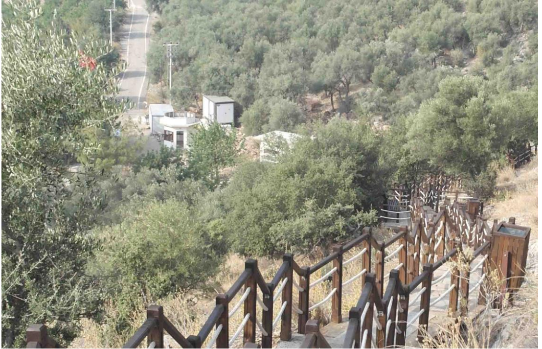
Resim 78: Karain Mağarası'nın yürüyüş yolunun başında bulunan ve inşaatı devam eden müze binası (Şebnem Kurtuluş Kıvanç 2015)
