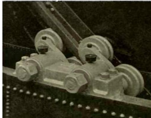
Şekil 3.17: Spiral kılavuzlu gazometrenin yukarı ve aşağı hareketini yönlendiren kılavuz rayı (Alwyn Meade'in Modern Gasworks uygulamasından).
