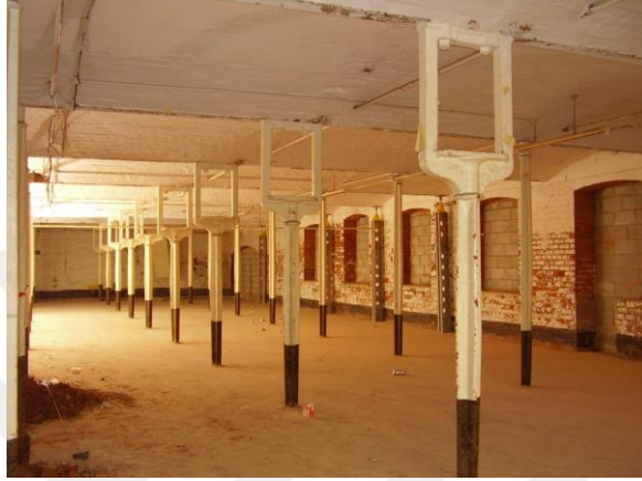
Şekil 2.7: Ditherington Flax Mill Değirmeni (Url 8).
