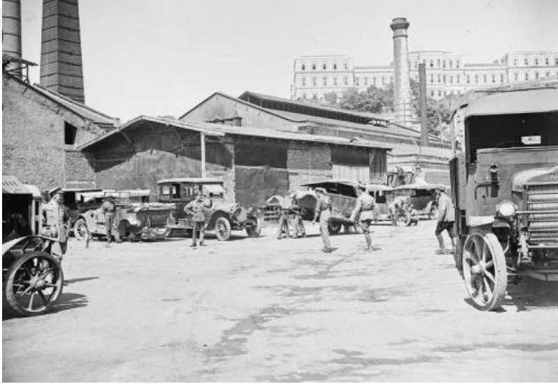
Şekil 3.43: Dolmabahçe gazhane tesisi (Url 94).
