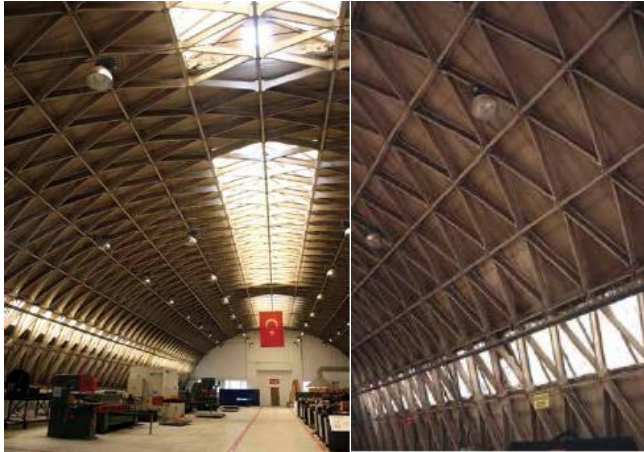
Şekil 2.20: Kayseri Uçak Fabrikası (Url 21).
