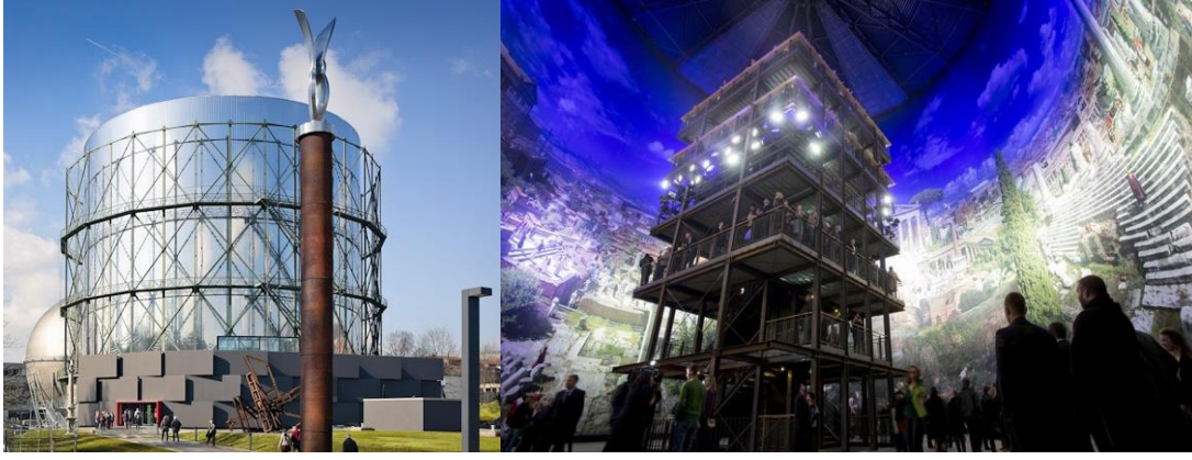
Şekil 3.35: Pforzheim Panometresi ve içerisine kurulmuş platform yapısı (Url 81, 82).
