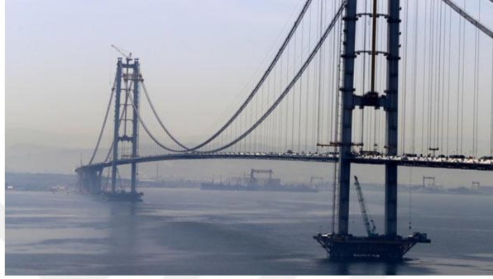
Şekil 2.35: İzmit Körfez Geçiş Köprüsü (Url 40).
