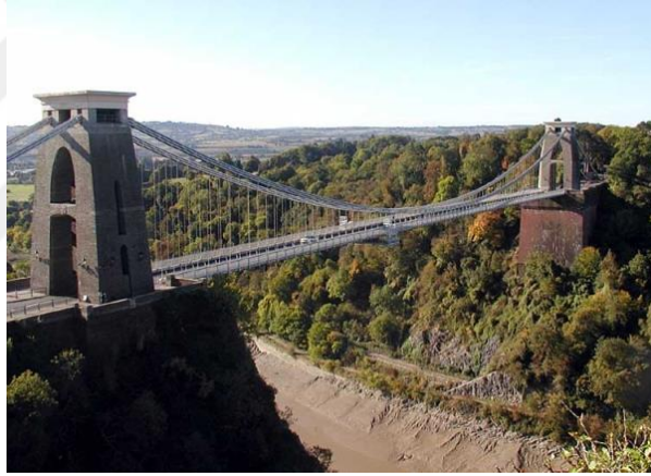
Şekil 2.6: Clifton Asma Köprüsü (Url 7).
