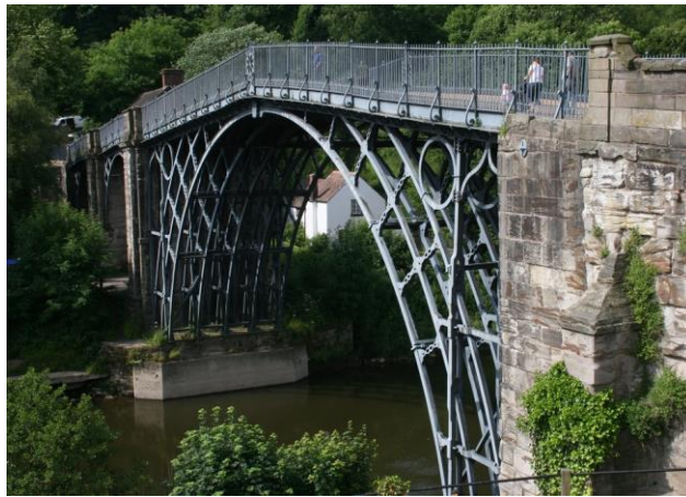
Şekil 2.1: Coalbrookdale Köprüsü (Url 1).
