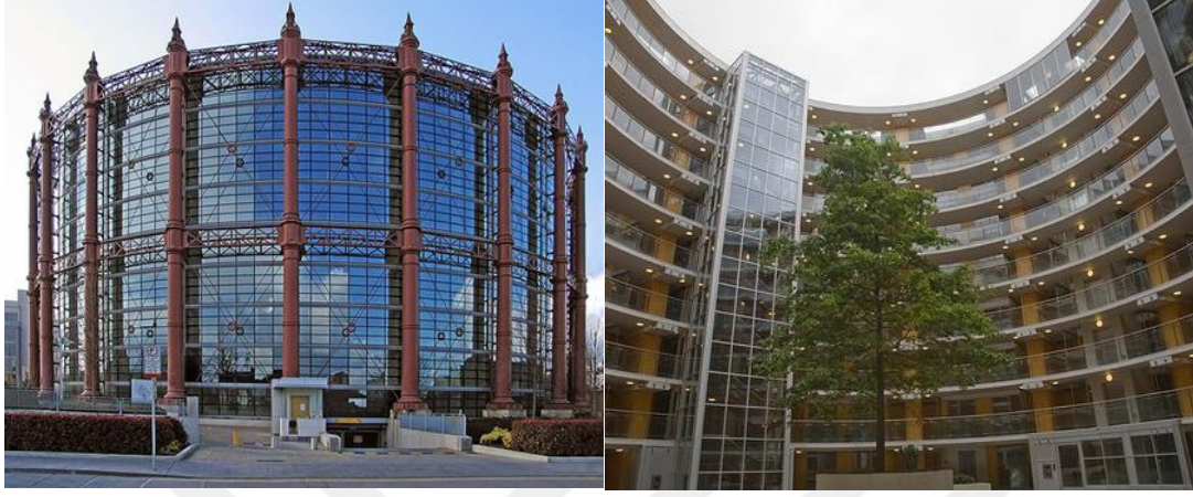
Şekil 3.33: Konut yapısına dönüştürülen yeni Dublin Gazometresi (Url 72, 73).
