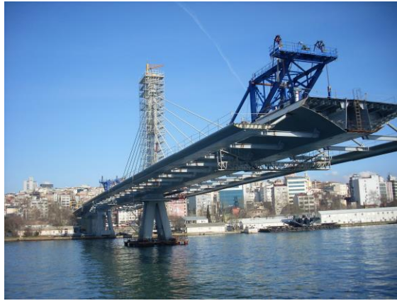
Şekil 2.34: Haliç Metro Geçiş Köprüsü (Url 38).
