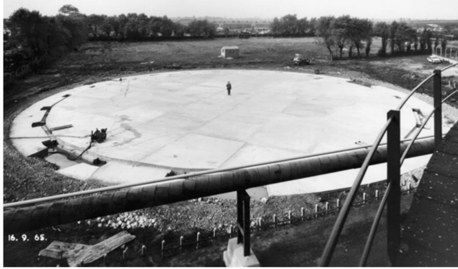
Şekil 3.6: Gazometre tankı için hazırlanan betonarme temel.
