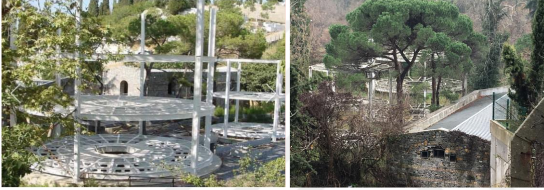
Şekil 3.36a: Gazometrelerin yeniden inşa aşamasındaki durumları (solda) (Url 89).
