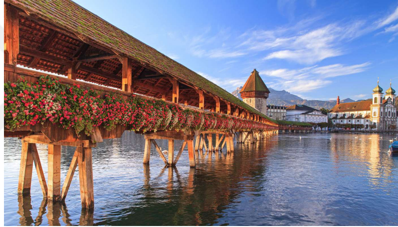
Şekil 1.1: Chapel Köprüsü, Luzern/İsviçre, yapım;1333 (Url 1).
