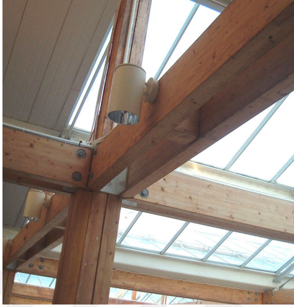
Şekil 2.24: Lamine ahşap bağlantı örneği (Url-7).
