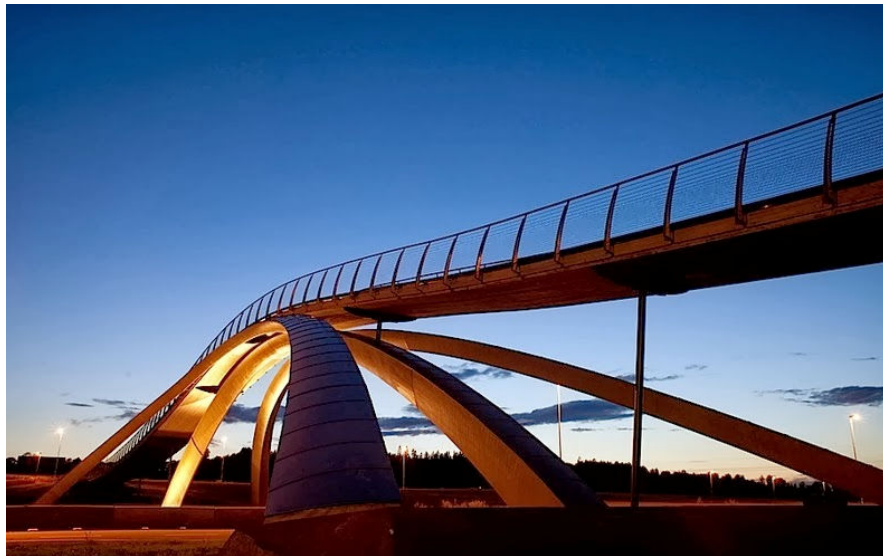
Şekil 2.16: Oslo Leonardo da Vinci Köprüsü (Url-5).
