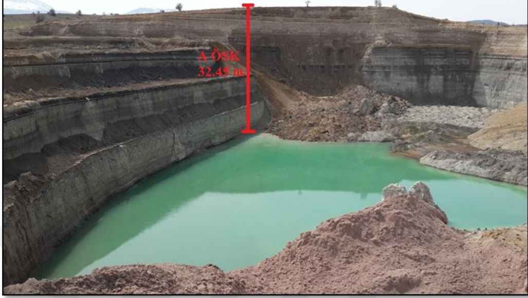
Şekil 1.2. Çalışma alanındaki Akçalar linyit işletmesindeki işletme yarmaları görüntüsü
