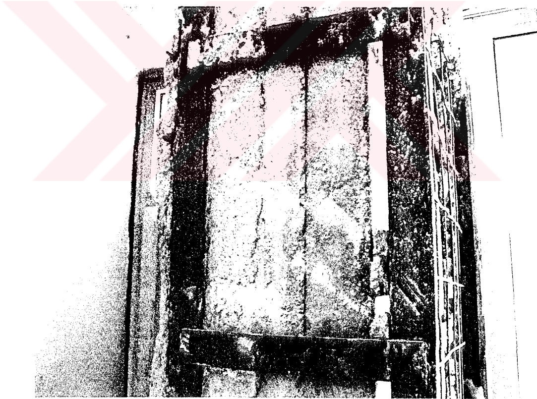
Resim 4.20. Binaların inřa ařamasında yapıldıėı ortaya ıkan elik profil takviyesi
