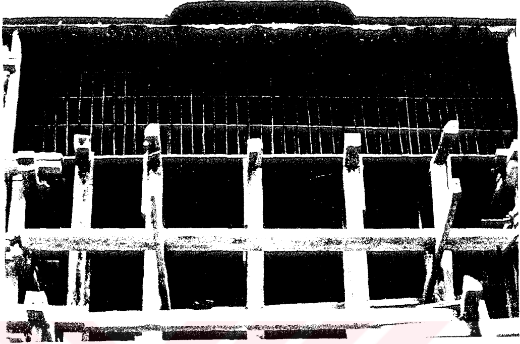
Resim 4.35. Safir sitesi giriş kısmında, 7 aksındaki kolonları bağlayan kiriş donatı detayı
