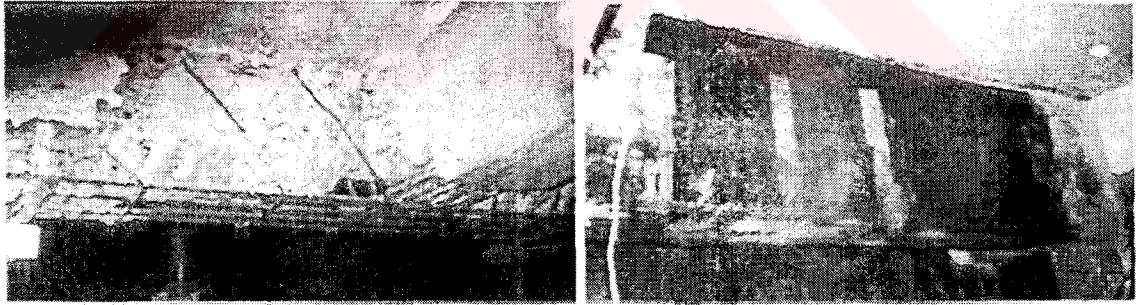
Resim 3.2. T kesitli bir kirişin çelik levhalarla kesme etkisine karşı güçlendirilmesi
