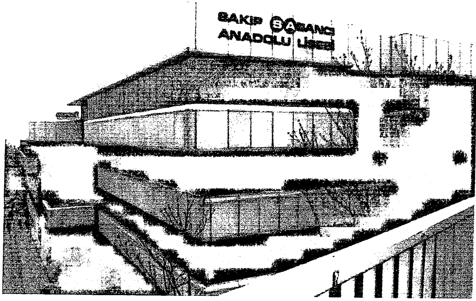
Resim 2.2. Klasik sistem ile inşa edilmiş Sakıp Sabancı Anadolu Lisesi
