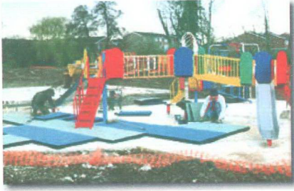
Şekil 2.11. Regupol soft safety tiles ile oluşturulan zemin döşemesi.
