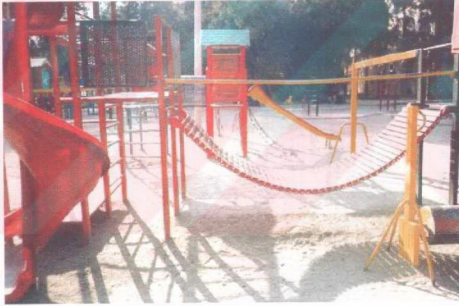
Şekil 4.43. Asma köprünün bariyeri mevcut değil.
