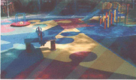
Şekil 2.15. Wetpour ile oluşturulan zemin döşemesi.
