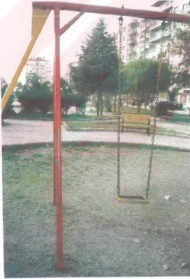
Şekil 4.15. Salıncağın oturma yeri kırık.
