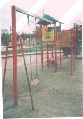
Şekil 4.18. Tırmanma kulesinin bariyerinin kırık olması, güvenlik açısından tehlike oluşturmaktadır.
