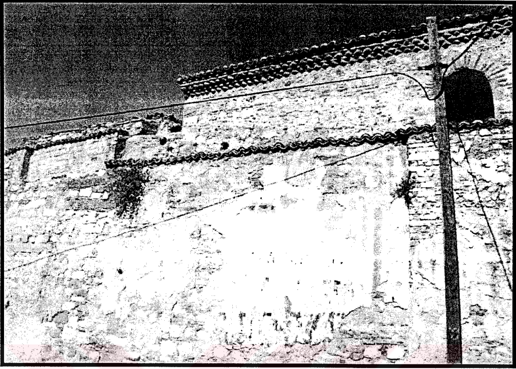
Resim 6. 19 Sarı Ahmet Paşa Hamamı Batı Cephesi
