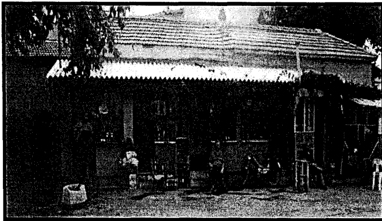
Resim 6. 57 Doğu Cephesine Yapılan Ek Birimler
