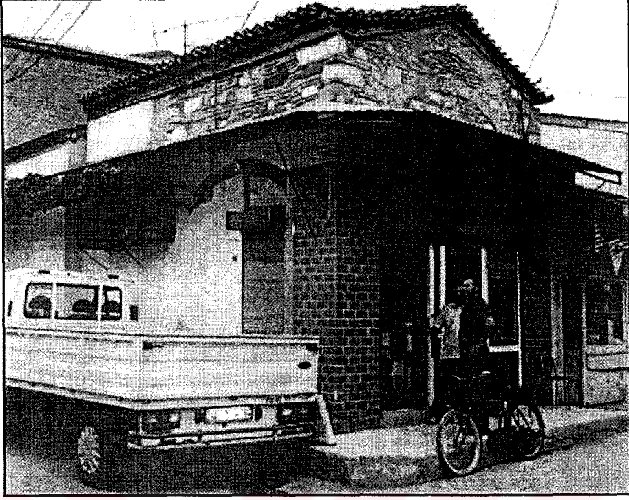
Resim 4. 5 Çarşıda 124 ve 119 Numaralı Sokak Köşesinde Bulunan Yapı
