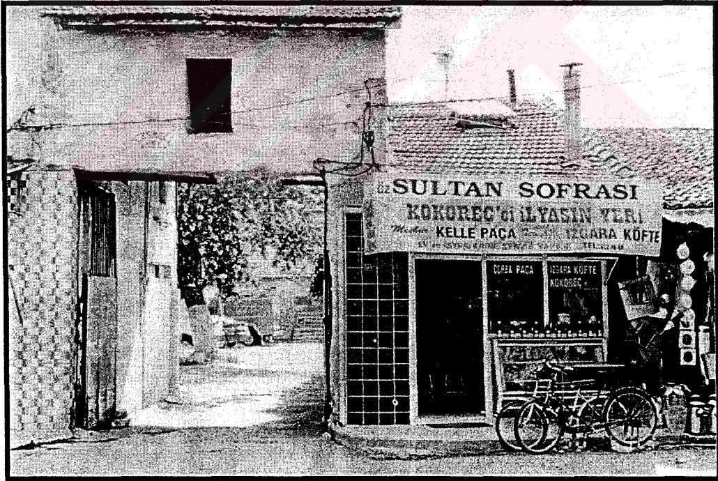
Resim 6. 36 Giriş Cephesinde Bulunan Lokanta
