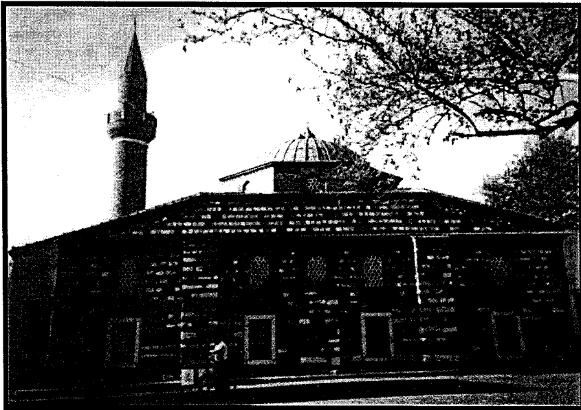
Resim 6. 7 Sarı Ahmet Paşa Cami Güney Cephesi
