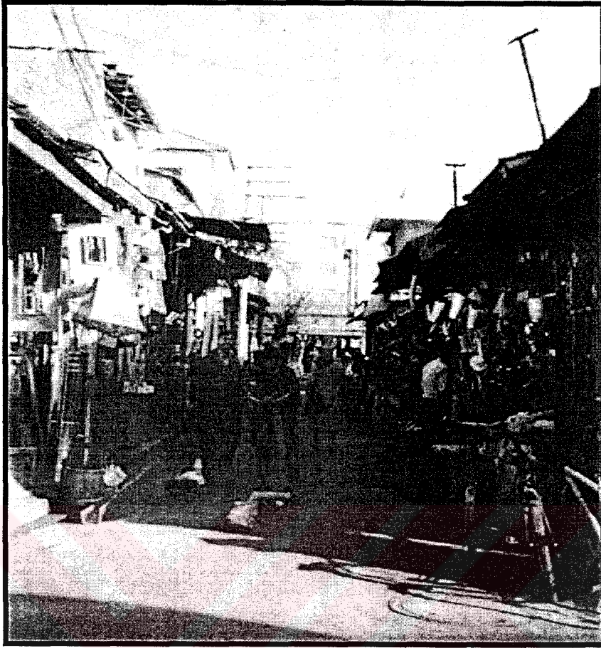
Resim 4. 1 Ticaret Merkezinde Bulunan Tenekeçiler Sokağı
