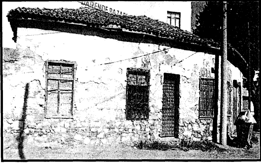
Resim 6. 49 İmarethane Cephesindeki Bozulmalar
