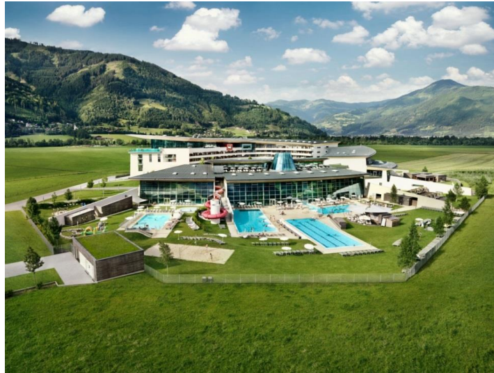
Şekil 3. 15 Tauren Spa otel görünümü [50]
