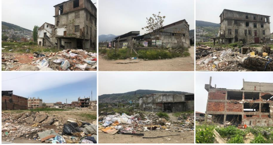
Şekil 4. 7 Çalışma alanında bulunan eski sanayi yapı kalıntıları
