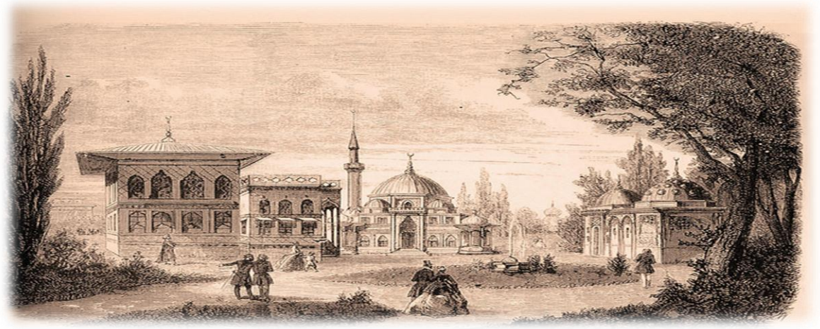
Türk Mahallesi genel görünüm (Cami , Türk Hamamı ve bir İstanbul köşkü örneği)
