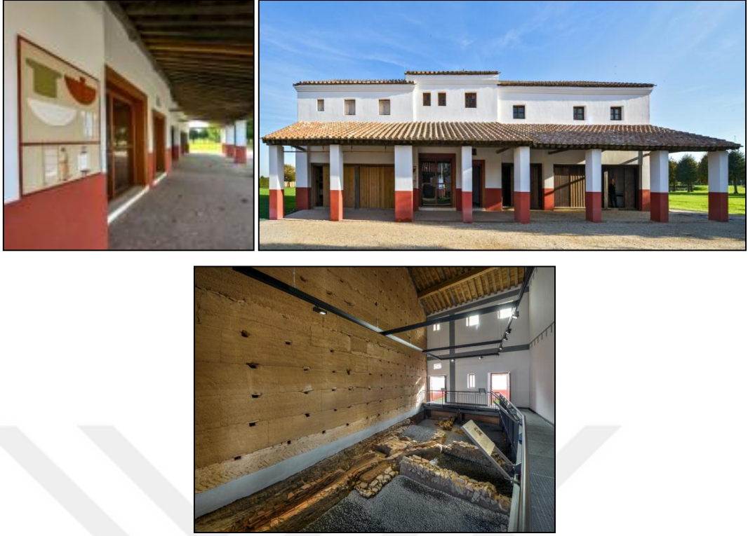
Şekil 2.8 Yeniden inşa edilen kerpiç evler [115]
