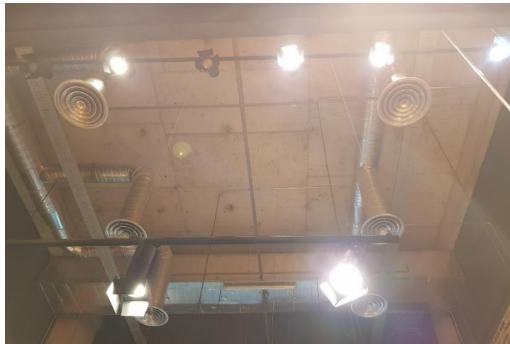
Görsel 153: Panora Avm Superdry Mağazası Havalandırma Kanalları (Kişisel Arşiv-2018)
