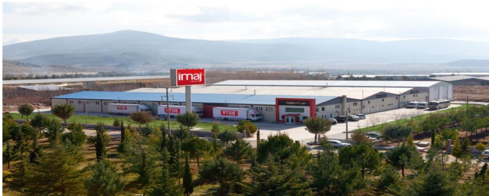
Şekil 3.1. Uygulama yapılan fabrikanın görünümü
