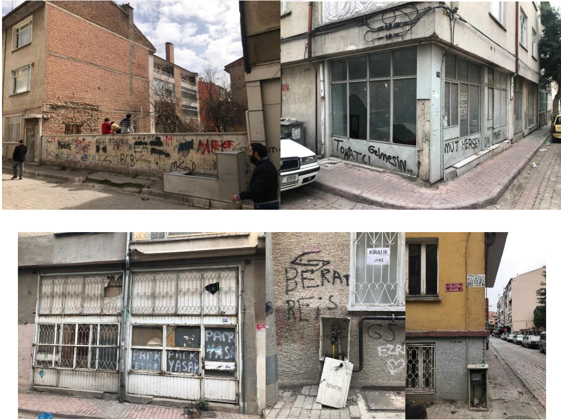
Fotograf 3.27. Çalışma alanı içerisindeki vandal hareketlere örnekler
