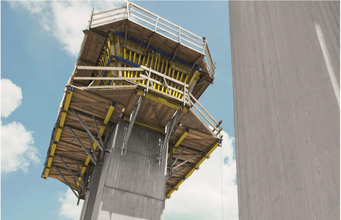
Şekil 3.5 Kalıp destek sistemi [2]
