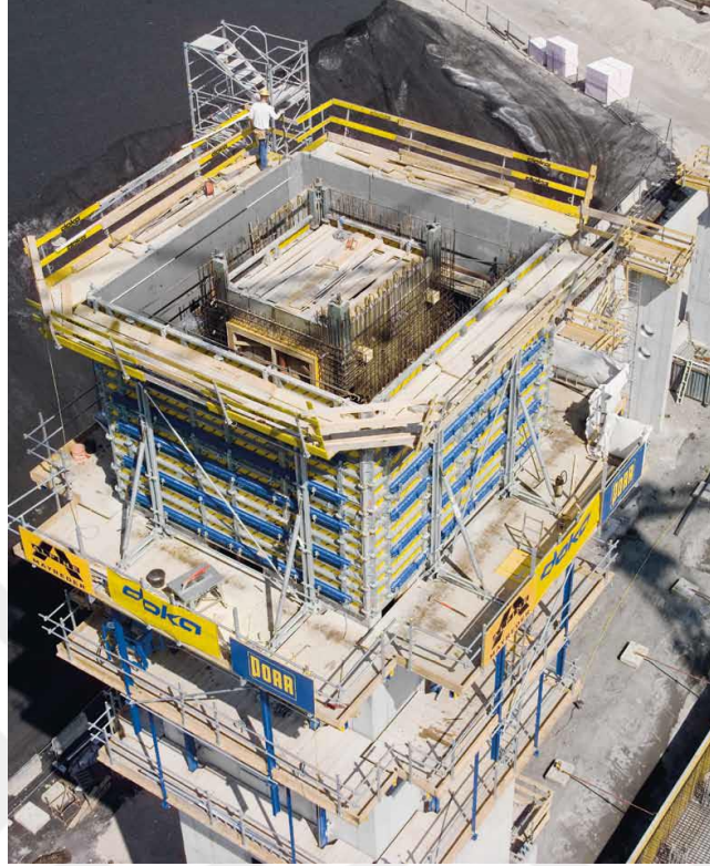
Şekil 3.6 Orta ayak ve iç kısmında şaft platformu [2]
