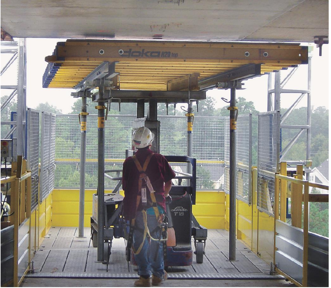
Şekil 2.2 Masa tipi döşeme kalıbı sistemi [2]
