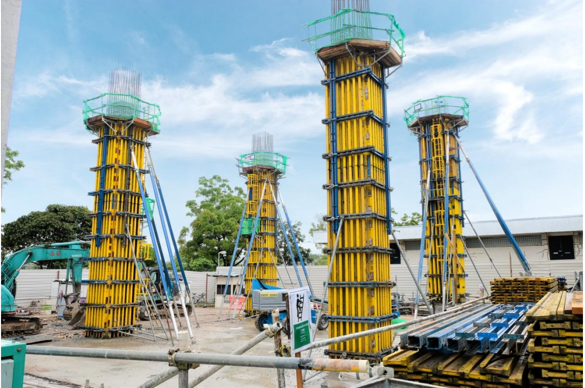
Şekil 3.3 Ahşap kirişli kolon kalıbı [2]
