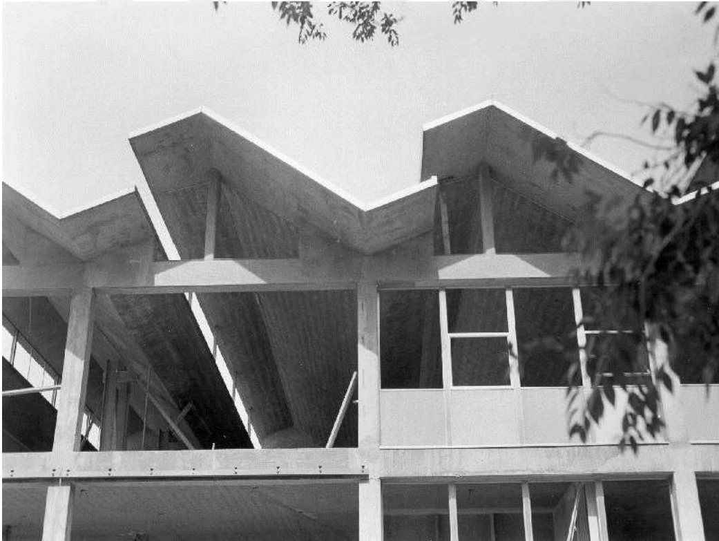
Şekil 2.18. Spor salonu ve kafeterya için katlanmış plak çatı örneği [15].
