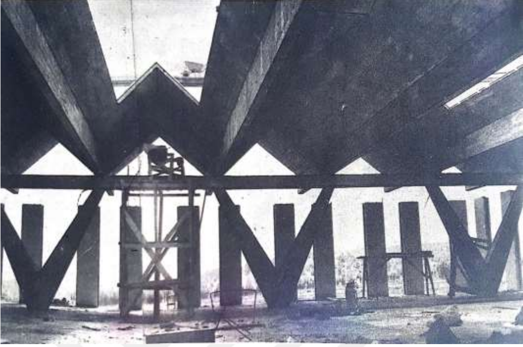
Şekil 2.19.c. Arçelik mensajı inşaatı iç görünümü [3].
