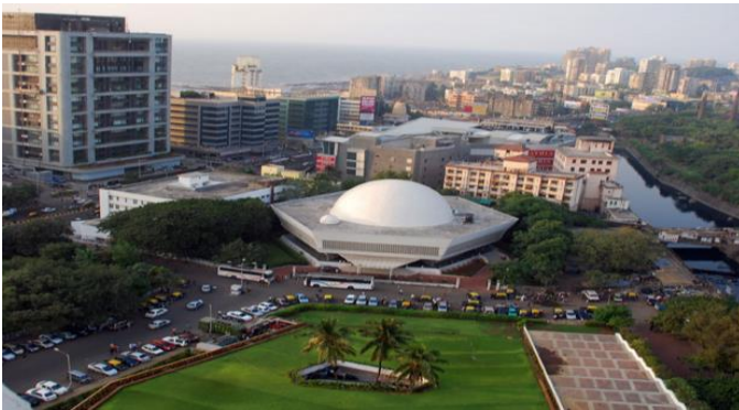
Şekil 4.53. Nehru Planetaryumu dış görünüş
