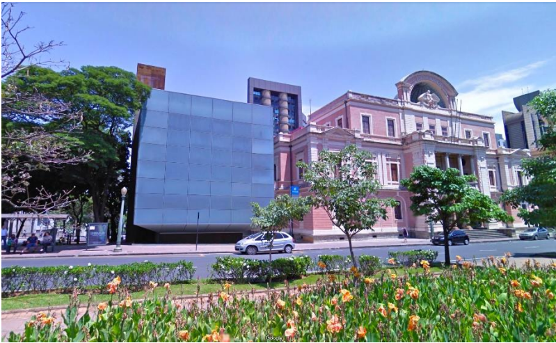
Şekil 4.73. Planetario do Espaco do Conhecimento dış görünüş
