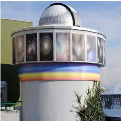
Şekil 4.33. Darüşşafaka Fatin Gökmen Planetaryumu dış görünüş
