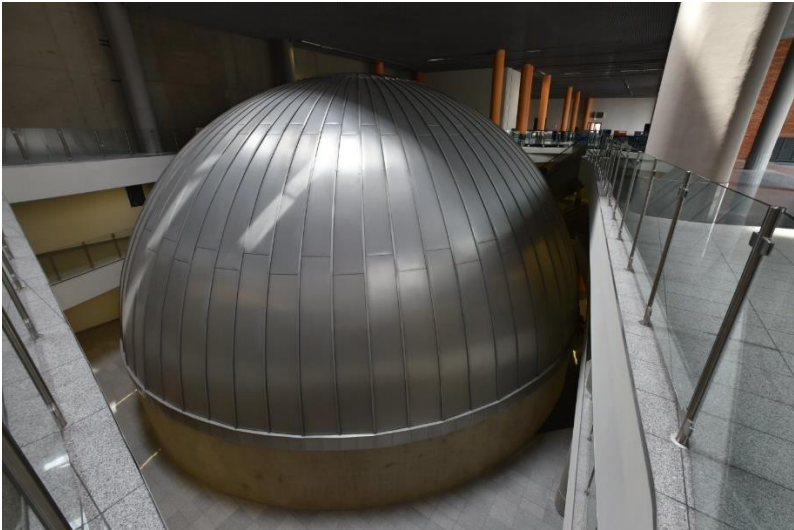
Şekil 4.61. EC1 Planetaryumu dış görünüş
