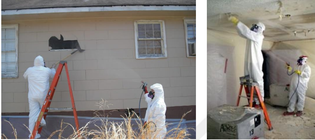
Şekil 4. 8 Asbestli yapı ürününün ıslak söküm tekniği kullanılarak yapıdan uzaklaştırılması [176].
