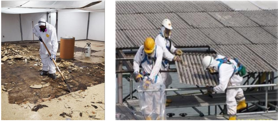
Şekil 4. 7 Asbestli yapı ürünlerinin yapıdan uzaklaştırılması [170], [171]
