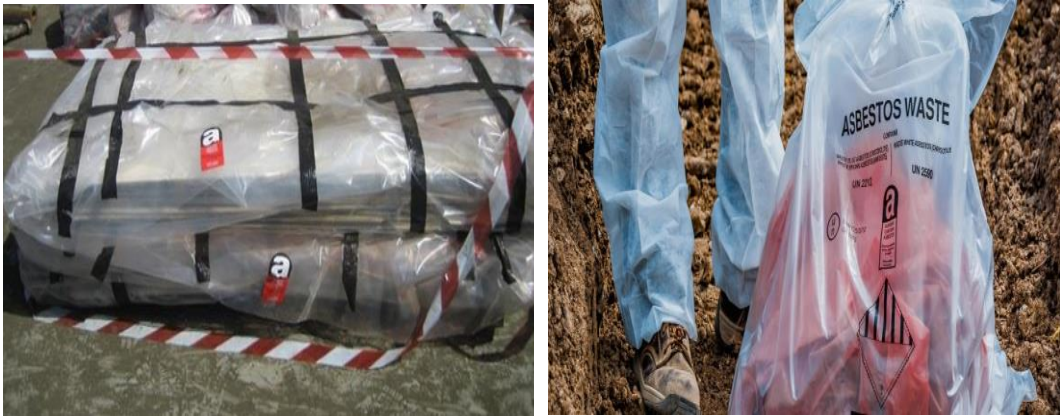
Şekil 4. 18 Asbestli yapı ürünü atıklarının paketlenmesi [213]
