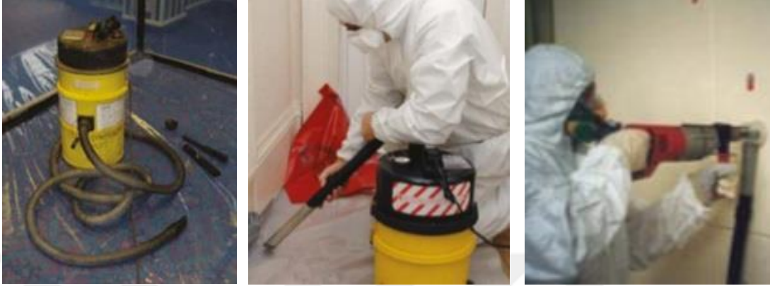
Şekil 4. 15 Asbestli çalışmalarda kullanılan HEPA filtreli süpürgeler [197], [198]
