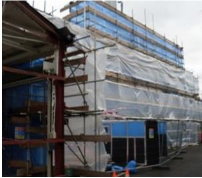
(1)Yapı dışında karantina kurulumu
