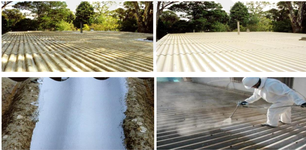
Şekil 4. 6 Asbestli yapı ürünü kullanılan bir çatıda kapsülleme yönteminin uygulanması [167]
