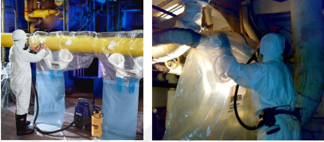
Şekil 4. 9 Asbestli yapı ürününün eldiven torbası kullanılarak yapıdan uzaklaştırılması [178]
