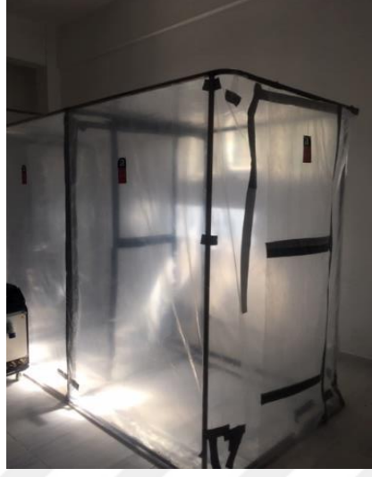
Şekil 5.8 Airlock ve baglock bölmeleri
