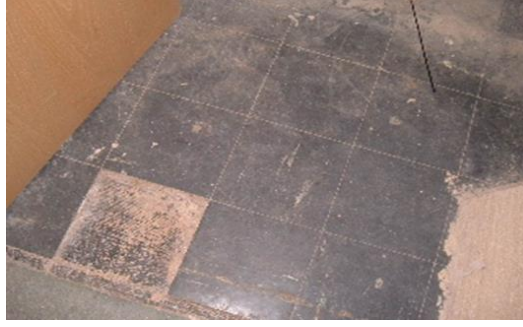
Şekil 4.10 Asbestli vinil yer döşemeleri
