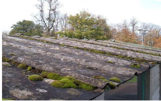
Şekil 4.11 Asbestli çimentodan mamul oluklu çatı kaplaması
