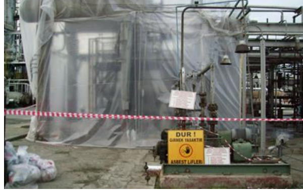
Şekil 5.3 Asbestli söküm alanına girişleri kısıtlayan uyarı levhaları
