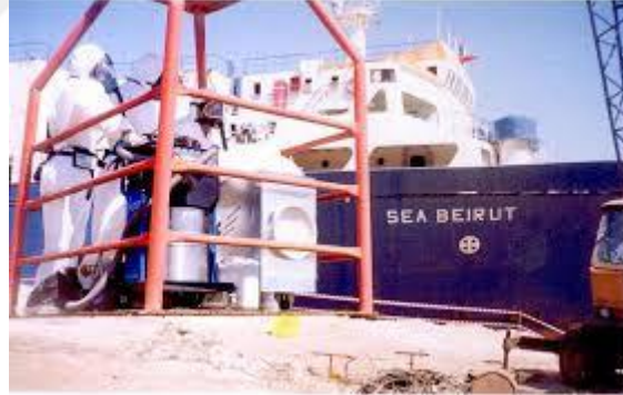
Şekil 4.1 Sea Beirut gemisinde tehlikeli atıkların söküm çalışması
